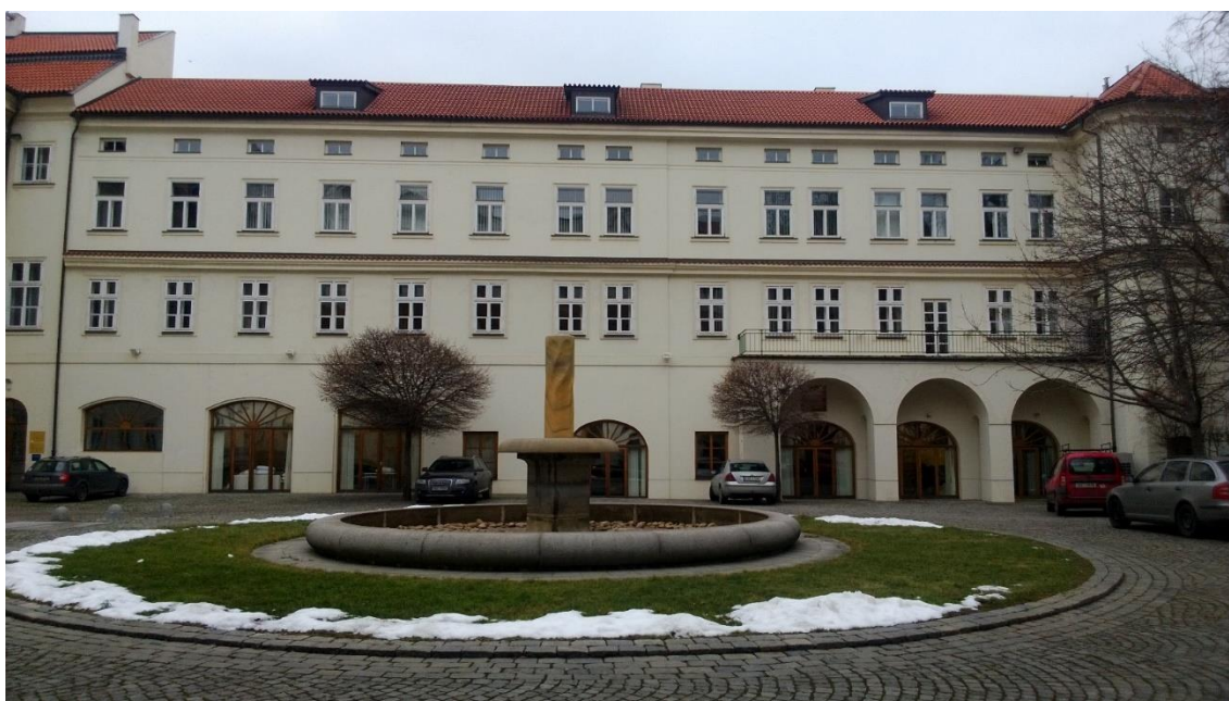
Obr. 9 – Pohled na jihovýchodní stranu budovy, severního křídla objektu
