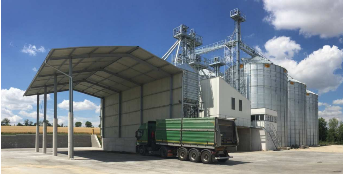
Obr. 1: Příjmový koš bývá proti povětrnostním vlivům chráněn halou, zde je příjmová část s košem v levé části fotografie
