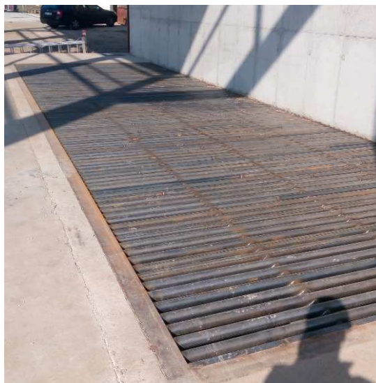
Obr. 9: Hotový stávající typ pojízdného roštu příjmového koše
