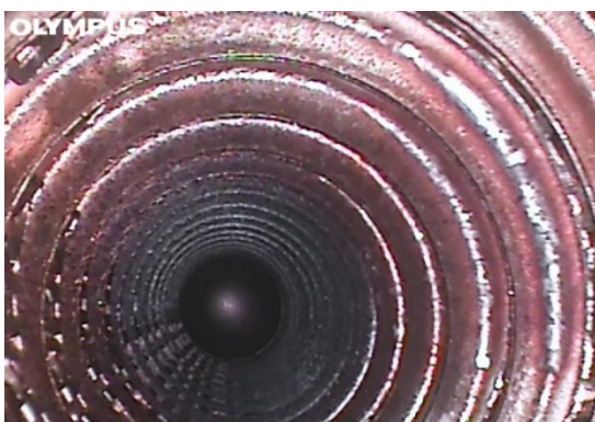
Obr. 10.2 Endoskopický pohled dovnitř prostorů čištěného chladiče před vyčištěním.
