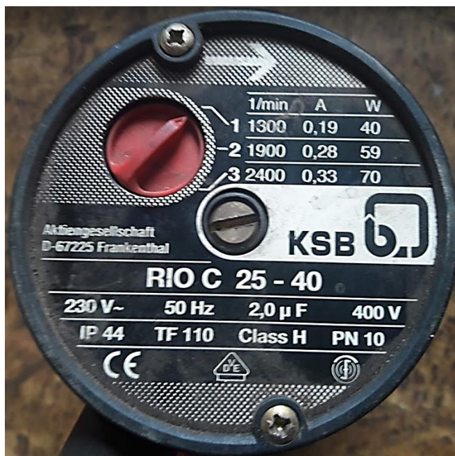
Obr. 9.6 Štítek teplovodného čerpadla KSB RIO C 25 – 40.
