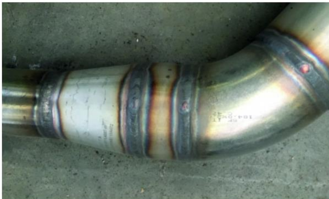
Obr. 5.2 Ukázka zoxidované vrstvy na povrchu korozivzdorné oceli podél svarů. [20]
