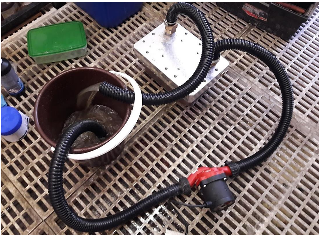
Obr. 9.11 Ukázka úspěšné zkoušky na těsnost celého čerpacího okruhu s vodou.
