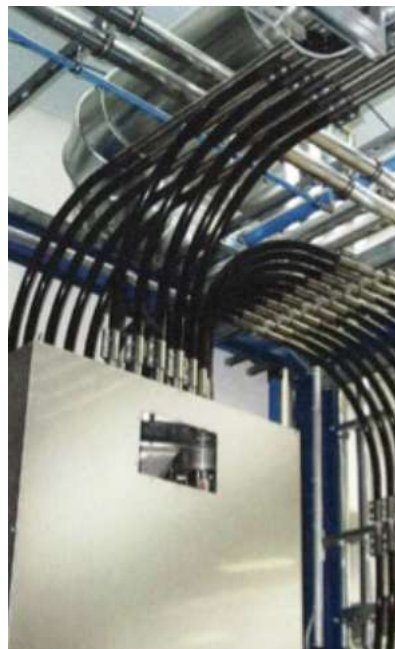
Obr. 5 – Ukázka centrálního rozvodu polymeru ke vstřikovacím strojům [1]
