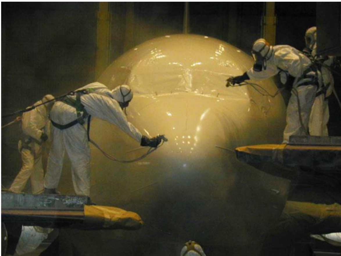
Obr. 14: Aplikace vrchního nátěrového systému na cestovní letadlo [3].
