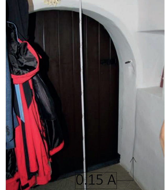
0.15 A: Kamenný portál z místnosti 0.15 do 0.15 zde byl dřív, než severozápadní stěna vřetenového schodiště.
