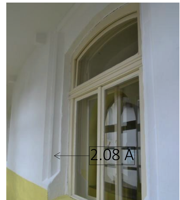
2.08 A: Okenní otvor v 2.07 jsou kamenná a jsou skryty pod omítkou. Tato profilovaná ostění jsou pozdně gotická.
