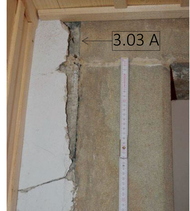
3.02 K: Stěna mezi 2.12 a 2.13.
