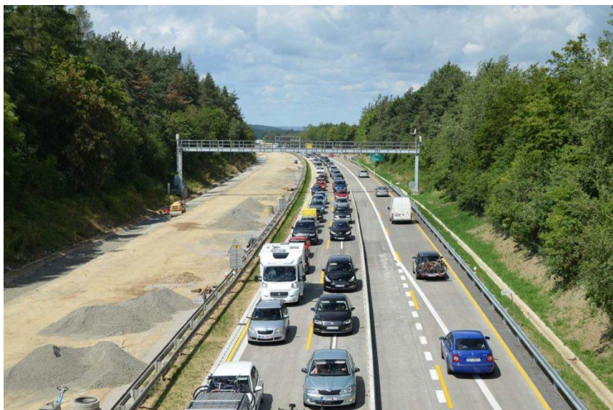
Obrázek 6.3: Vedení dopravy v režimu 2+2 v rámci modernizace dálnice D1
