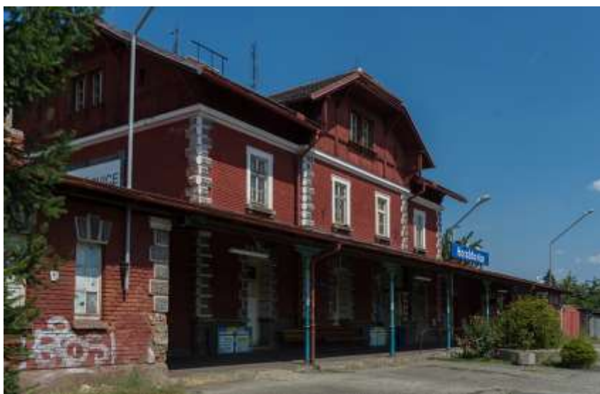
Obr. 32: Výpravní budova ŽST Horažďovice (zdroj: autor práce)
