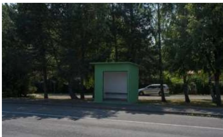
Obr. 49: Zastávka Horažďovice, u mostu směrem k žel. st. (zdroj: autor práce)
