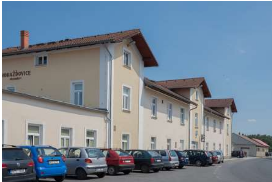
Obr. 30: Výpravní budova ŽST Horažďovice předměstí (zdroj: autor práce)
