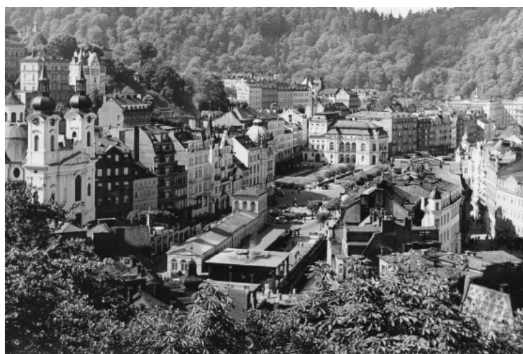
Pohled na dřevěnou kolonádu a Lázně II, 1940. (obr.35)
