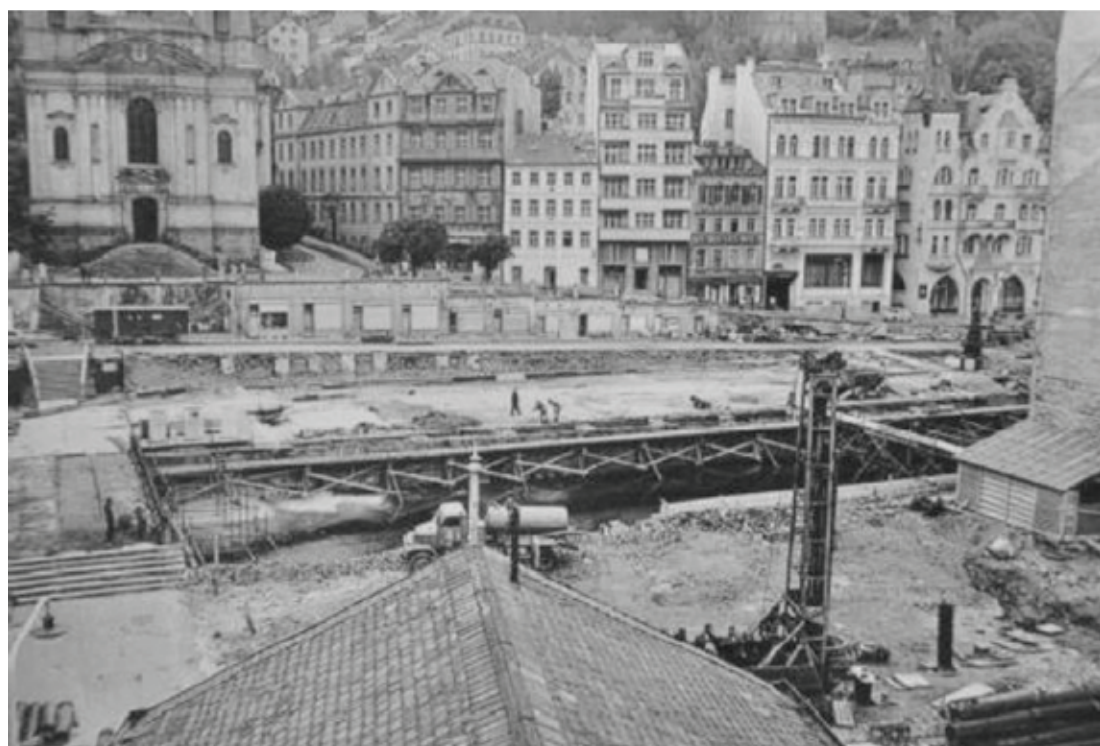
Prostor u Vrídla po odstranění dřevěných provizorií. Lze vidět členitost původního terénu. Pod kostelem sv. Máří Magdalény původní terasa s obchody, 1967. (obr.68)
