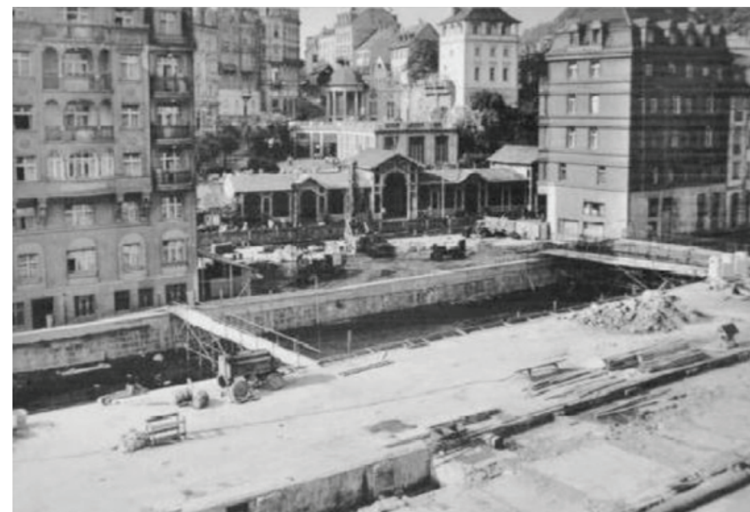
Přípravné práce pro výstavbu nové Vrídelské kolonády, průhled na dřevěnou Tržní kolonádu po demolici domů na nábřeží, 1967. (obr.69)
