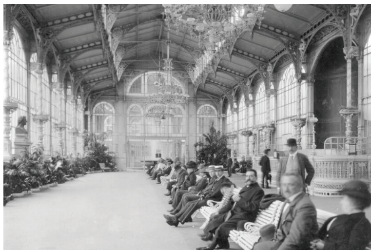
Interiér Vřidelní kolonády, zastropení bylo řešeno nosníky „hammer beam“, umožňující otevřít prostor bez nutnosti vkládání sloupů, vpravo podium pro orchestr, 1913. (obr.58)
