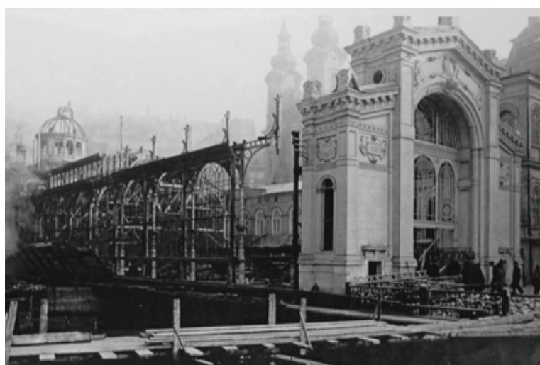
Rozebírání ocelolitinové konstrukce Vřidelní kolonády, leden 1939. (obr.60)
