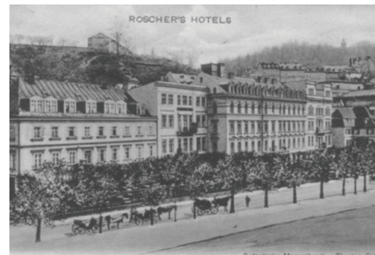
Divadelní náměstí před demolíci domů. (obr.11)
