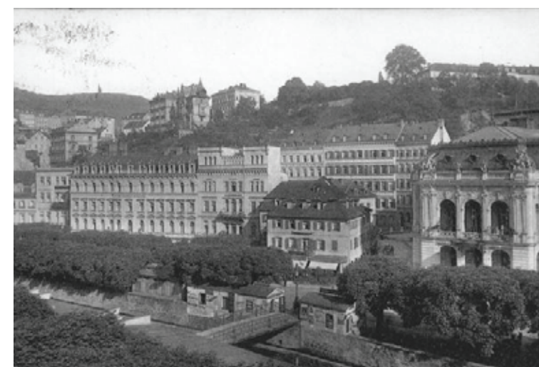
Divadelní náměstí před demolíci domů. (obr.12)
