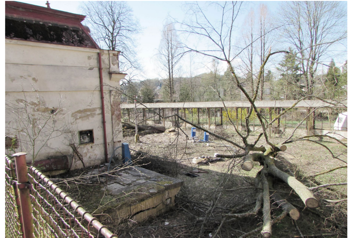
△ přední část areálu s budovou prameníku a kolonádou
