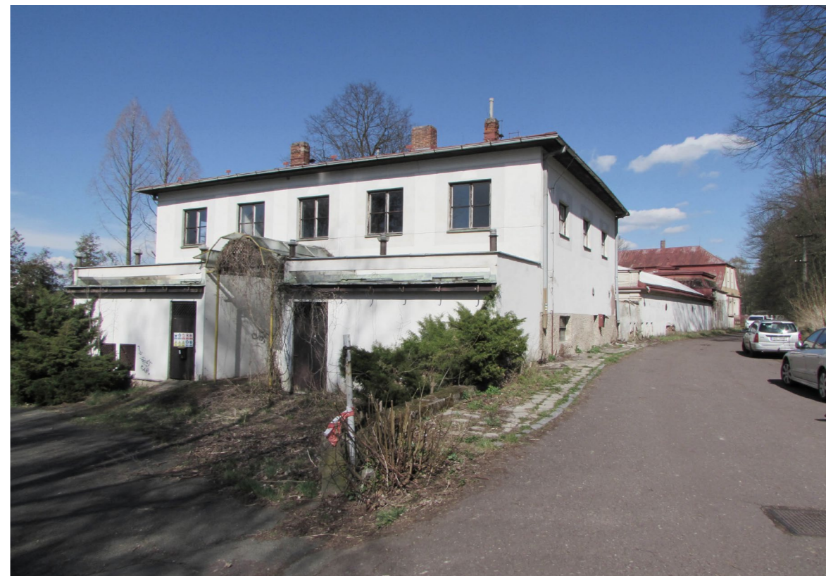
△ vstupní budova lázní Bělouves s restaurací
