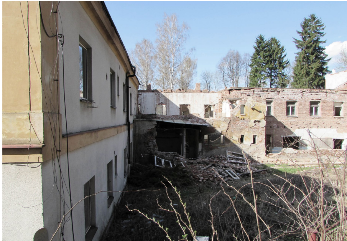
△ pohled na budovu Helena II se návazností na Helenu I [vlevo]
