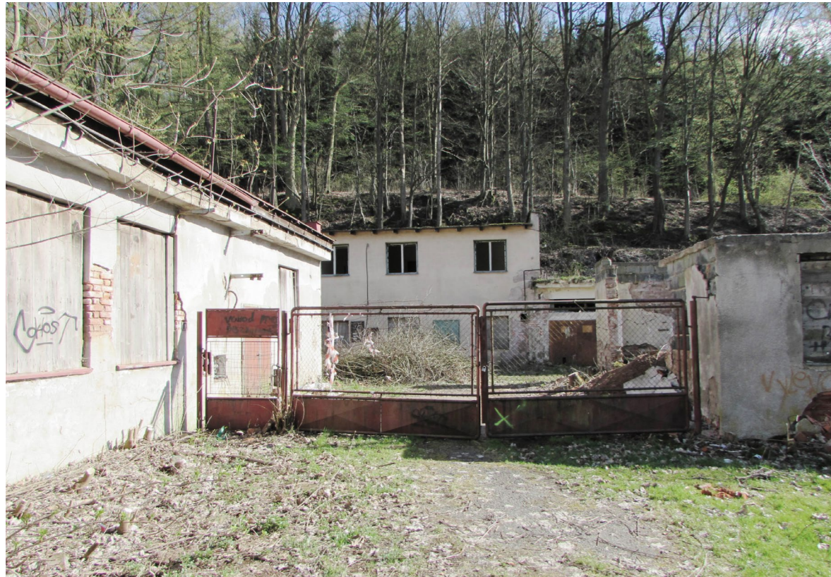
△ vjezd do zadní části areálu s technickým zázemím [kotelna, garáže, dílny]
