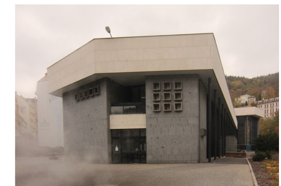
Obr. 31: Jižní průčelí kolonády
