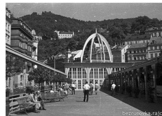
Obr. 11: Tesařská konstrukce vyzdvížená nad Vřídlem
