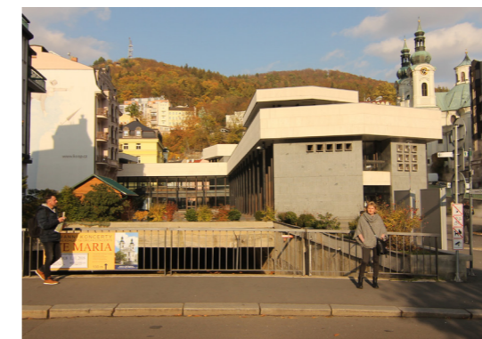
Obr. 30: Přemostění řeky Teplé
