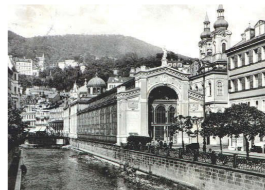
Obr. 8: Zděné průčelí litínové kolonády
