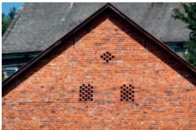
Obr.2: Větrací otvory na staré stodole
