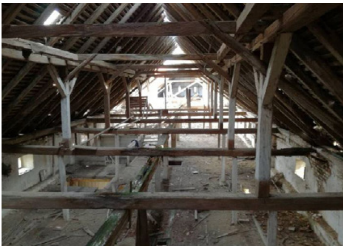
Obr.5: Pohled na původní krov od jižního štítu východní budovy
