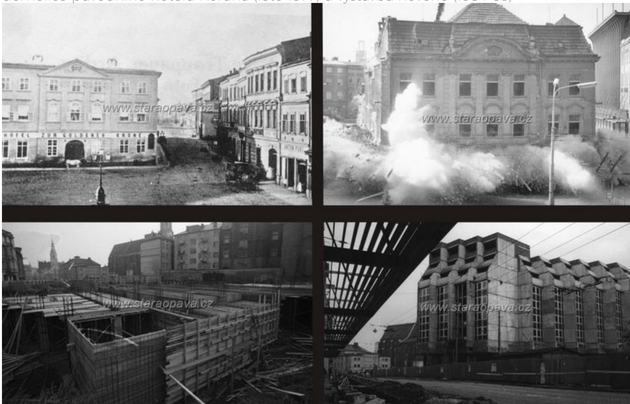
demolice původního hotelu Koruna (léto 1977) a výstavba nového (1984-85)
