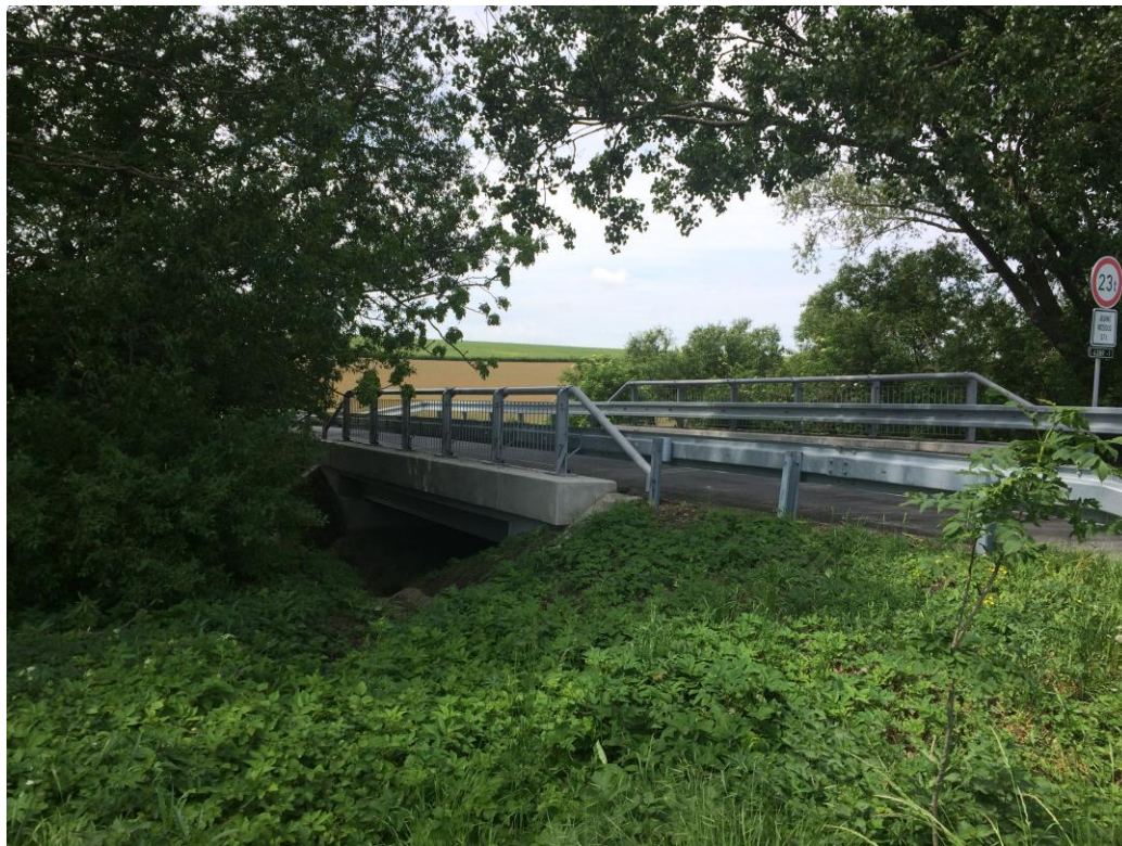
Fotografie 1 – most na silnici III/4389 přes Blazický potok
