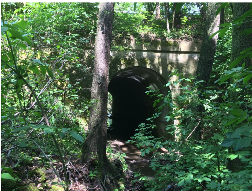
Fotografie 6 – Klenutá propust přes Moštěňku, nahoře silnice III/4389
