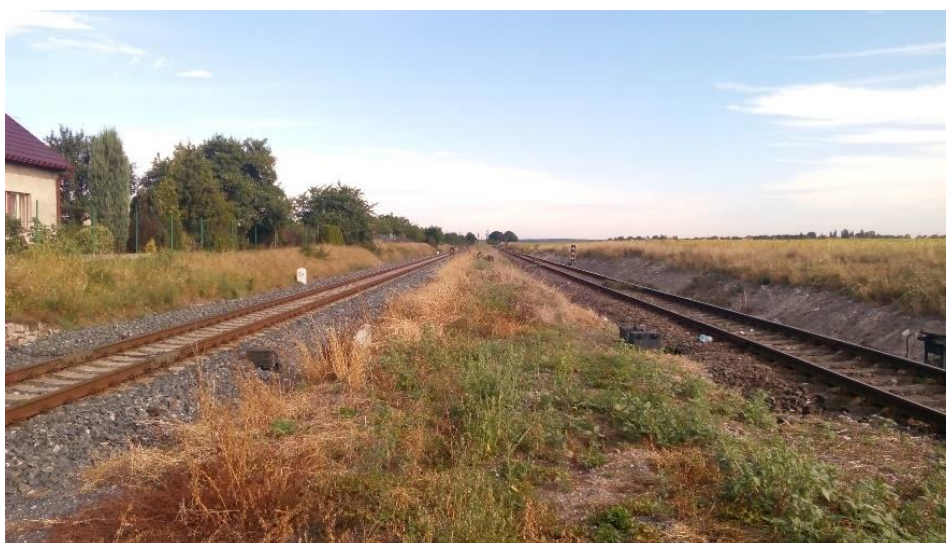
Obrázek 24: Pohled na železniční tratě č. 071 a č. 061 v místě plánovaného nadjezdu
