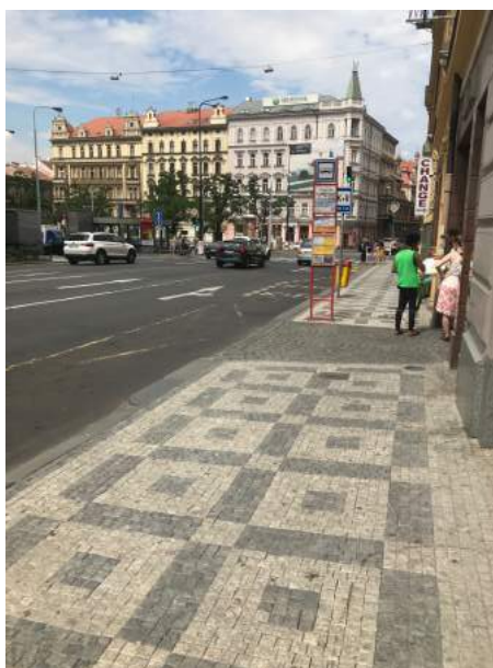
Obrázek 16 - Nástupiště bez využití signálního a varovného pásu (autor)
