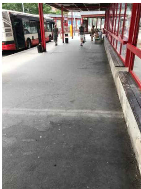
Obrázek 12 - Autobusové nástupiště bez varovného pásu, Anděl/Na Knížecí (autor)
