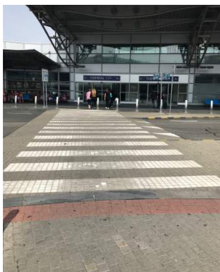
Obrázek 22 - Chybící vodící pás přechodu, Terminál 1 (autor)
