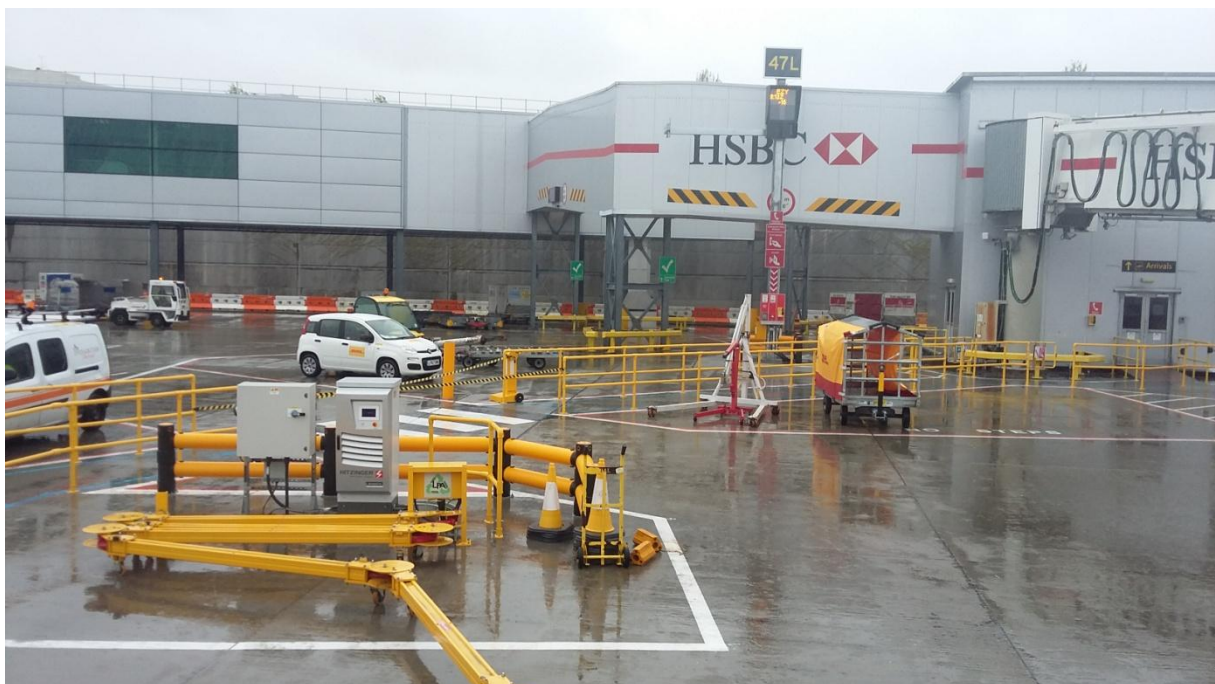
Obrázek 7- FEGP typu "krokodýl" na letišti Londýn Gatwick [Zdroj: vlastní]
