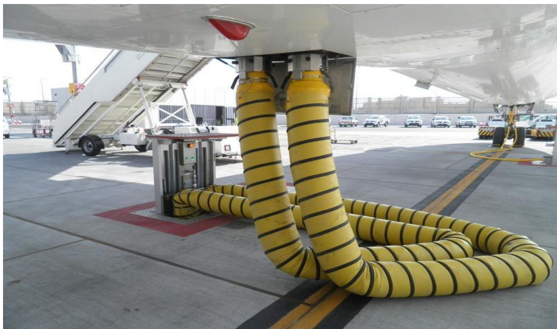
Obrázek 14- Klimatizační jednotka v instalaci "pop-up pit", Dubaj [Zdroj: cavotec.com]
