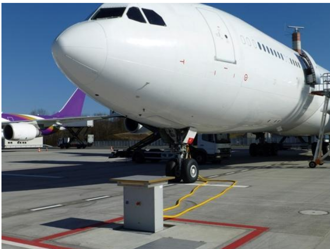
Obrázek 9 - FEGP "pop-up pit" typu [42]
