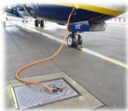
Obrázek 10 - FEGP umístěný v podzemní šachtě [34]
