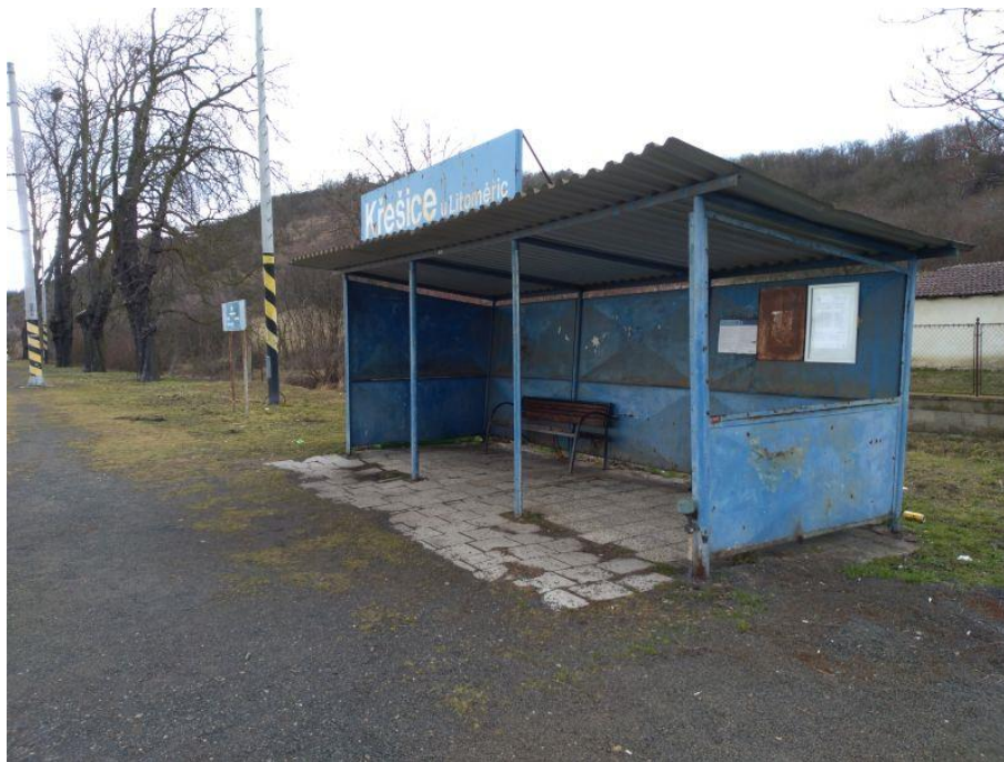
Obrázek 8: Přístřešek v Křešicích u Litoměřic [autor]
