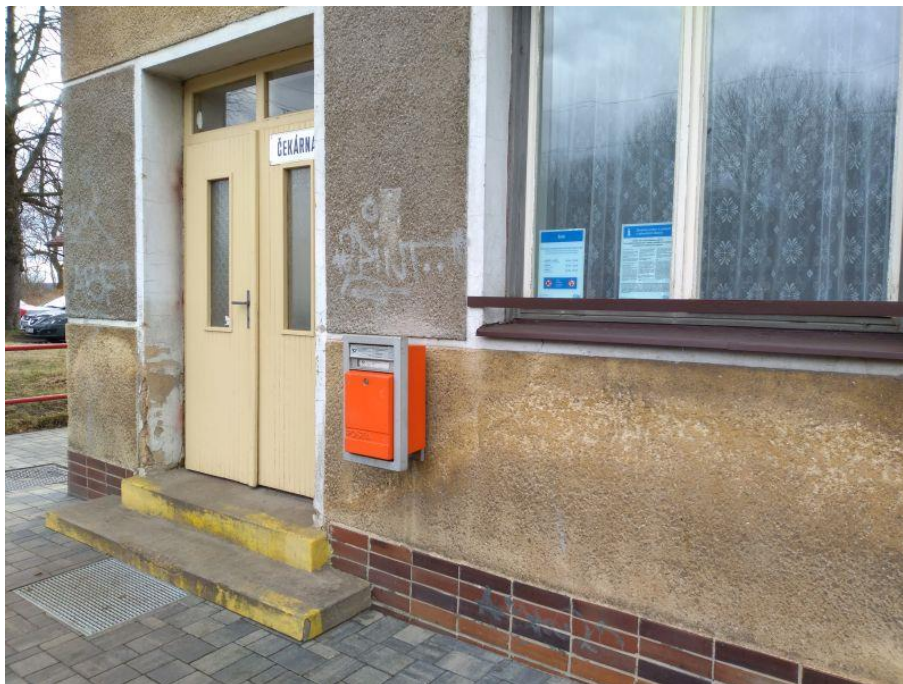
Obrázek 12: Bariérový přístup do budovy ve Štětí [autor]
