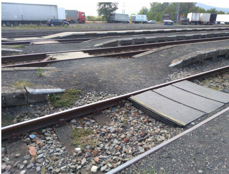
Obrázek 11: Úrovňový přechod mezi nástupišti ve Velkých Žernosekách [autor]
