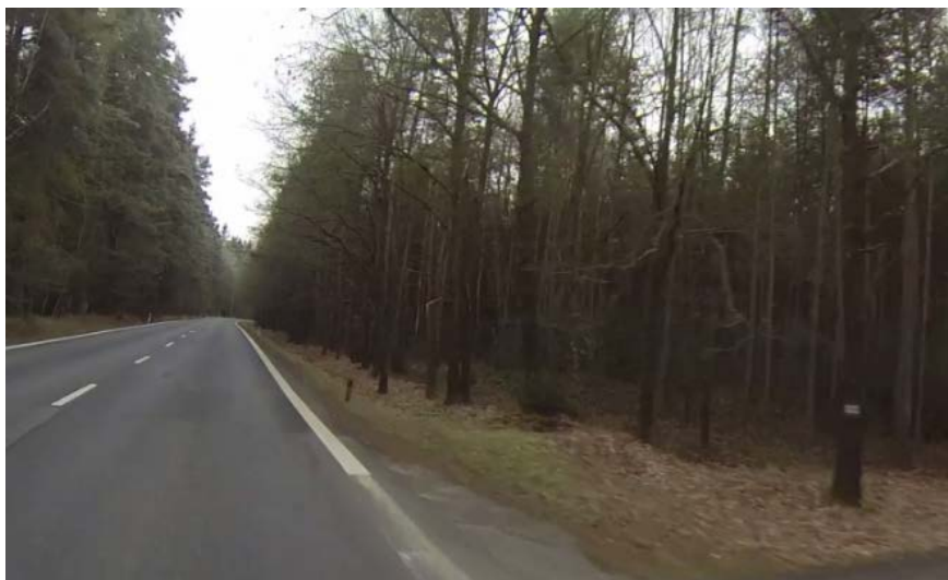
Obrázek 9 - Dopravně bezpečnostní deficit na silnici I/24 [15]
