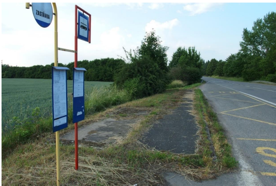
Obrázek 32 - zastávkové stanoviště ČKD II zast. směrem z Kutné Hory
