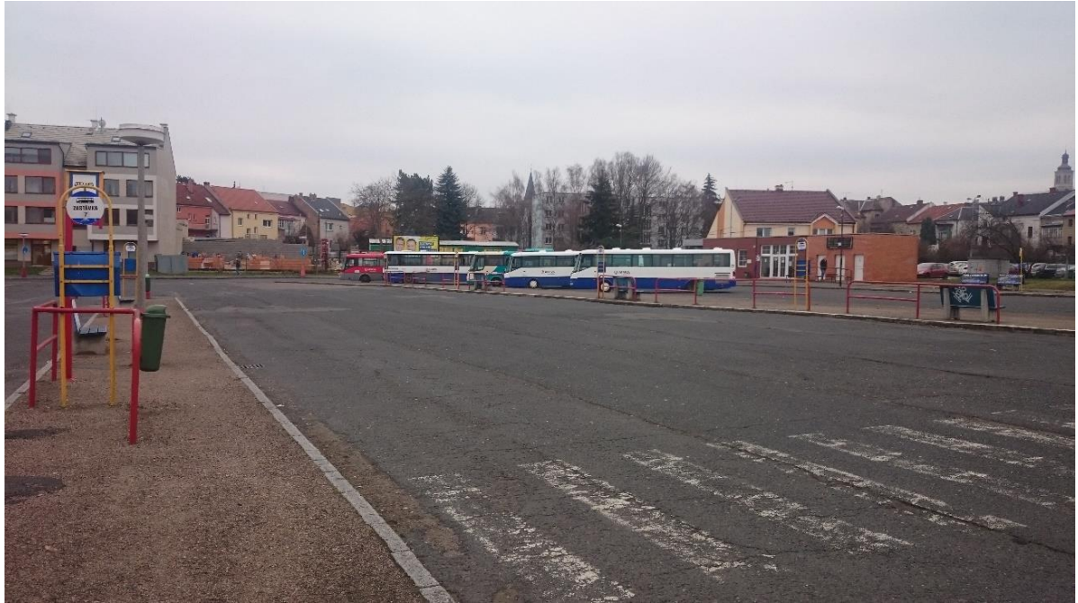
Obrázek 14 - stanoviště, odstav a odbavovací budova na autobusovém nádraží
