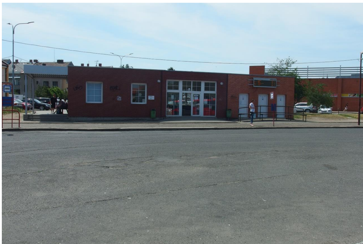
Obrázek 13 – odbavovací budova na autobusovém nádraží
