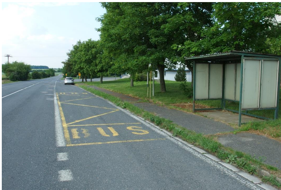
Obrázek 107 - zastávka ZZN ve směru do Kutné Hory
