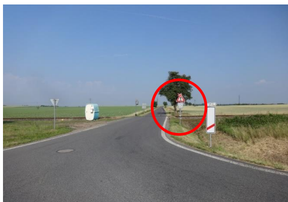
Obrázek 29 – SDZ A 22 „Jiné nebezpečí“ zcela zakrývá výstražník před místem přejezdu P4955 [58]
