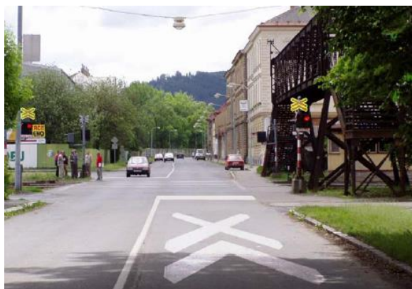
Obrázek 12 – Ukázka zlepšení postřehnutelnosti železničního přejezdu pomocí opakování výstražného kříže na vozovce [41]
