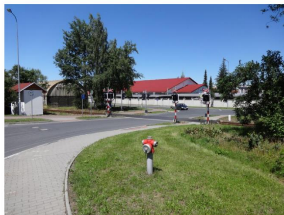
Absence retroreflexního podkladu SDZ A 32a "Výstražný kříž pro železniční přejezd jednokolejný"
