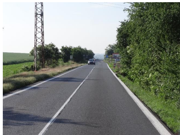
Obrázek 39 – Ukázkou dobrého technického stavu VDZ a vozovky v místě železničního přejezdu P2106 [68]
