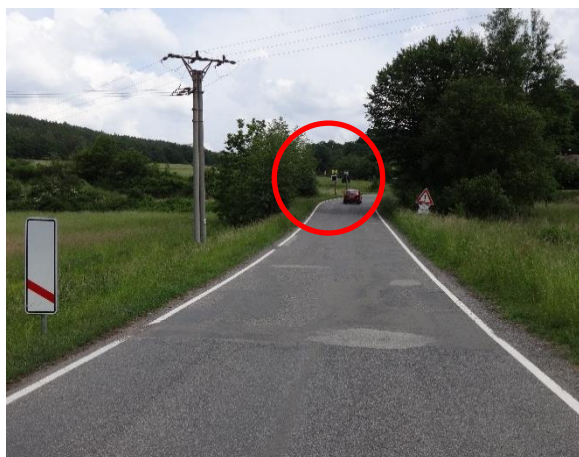
Obrázek 36 – Ukázka zlepšení postřehnutelnosti železničního přejezdu P551 pomocí opakování výstražníku i po levé straně vozovky [65]
