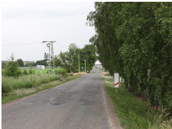
Obrázek 48 - Větve stromu zcela zakrývají výhled na výstražný kříž. Údržbu této zeleně má na starosti správce pozemní komunikace [75]
