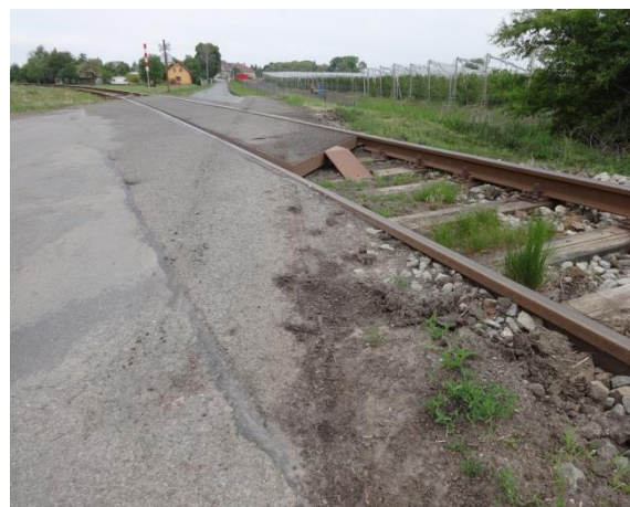
Obrázek 41 – Ukázka náhle změny šířky vozovky před a za železničním přejezdem P3195 na silnici III/27938 mezi obcemi Oubruce a Lítkovice [70]
