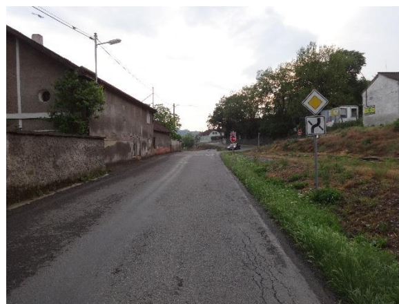
Obrázek 34 – Nevhodné provedení SDZ E 2b, kde je postrádáno vyznačení drážní cesty [63]
