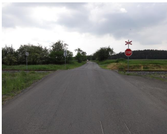
Obrázek 44 a 45 – Ukázka nevhodného lomu nivelety pozemní komunikace v prostoru přejezdu P3015 na silnici III/27314 u obce Hled'sebe [72]
