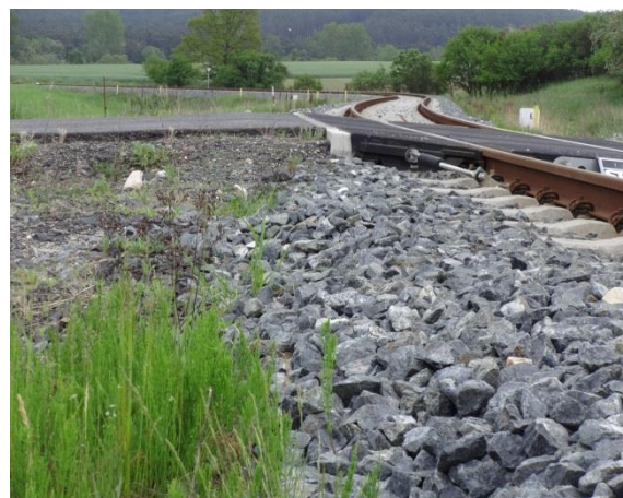
Obrázek 44 a 45 – Ukázka nevhodného lomu nivelety pozemní komunikace v prostoru přejezdu P3015 na silnici III/27314 u obce Hled'sebe [72]
