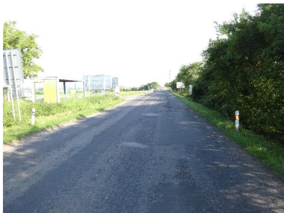
Obrázek 38 – Ukázkou absence VDZ a neadekvátního stavu vozovky v místě přejezdu P2106 [67]
