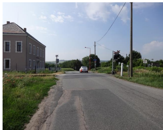
Obrázek 26 - Ukázka zhoršené postřehnutelnosti výstražného kříže v místě železničního přejezdu P5904 [55]
