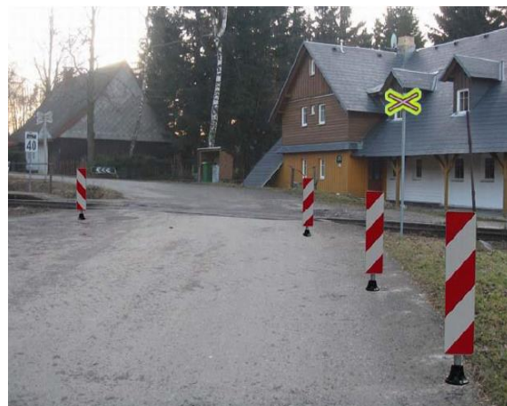
Obrázek 42 a 43 – Ukázka možného řešení při náhlém zúžení vozovky v prostoru přejezdu [71]
