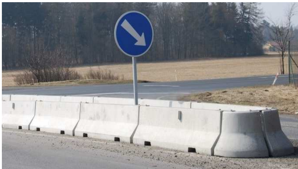
OBRÁZEK 3.6: Betonové svodidlo [8]
