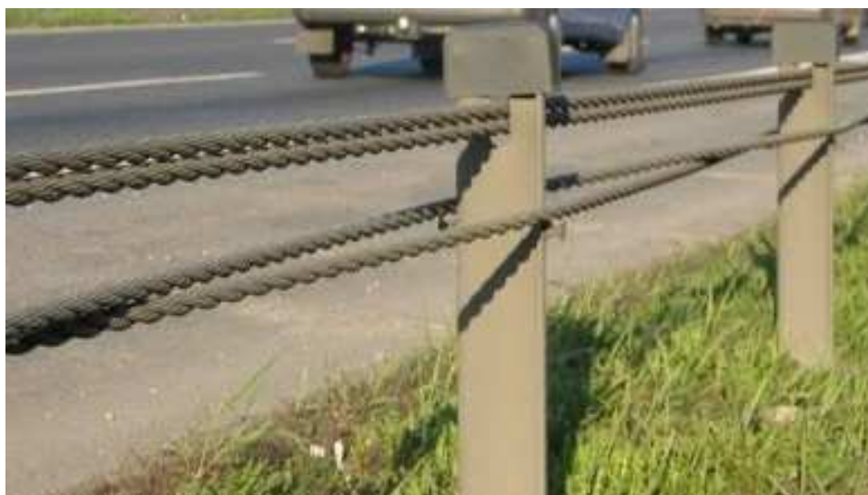
OBRÁZEK 3.4: Lanové svodidlo [12]
