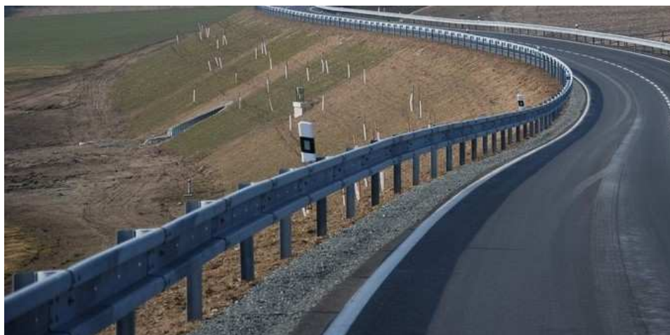
OBRÁZEK 3.3: Jednostranné ocelové svodidlo NH4 [11]
