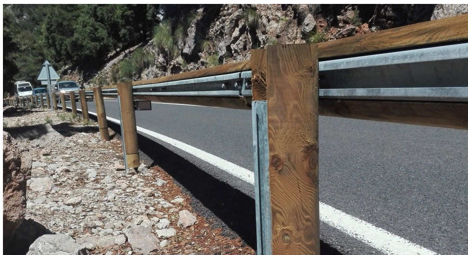
OBRÁZEK 3.5: Dřevoocelové svodidlo
