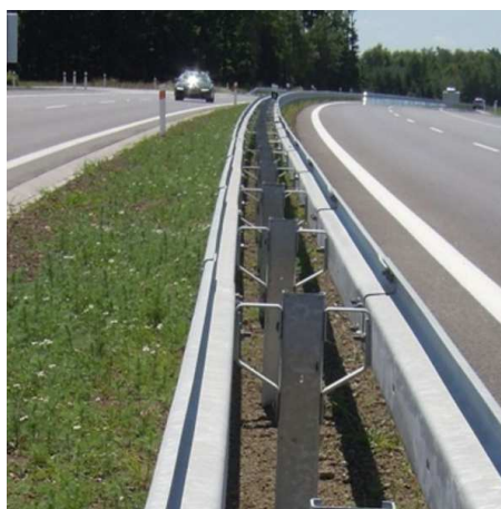
OBRÁZEK 3.2: Oboustranné svodidlo [8]
