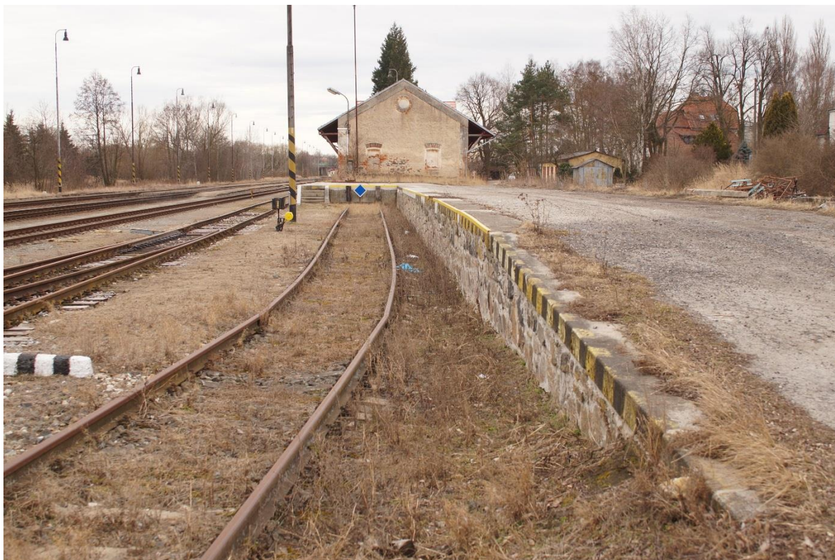
Obrázek 8: Pohled na rampu u kolejí 5c a 7, nevyužívané skladiště
