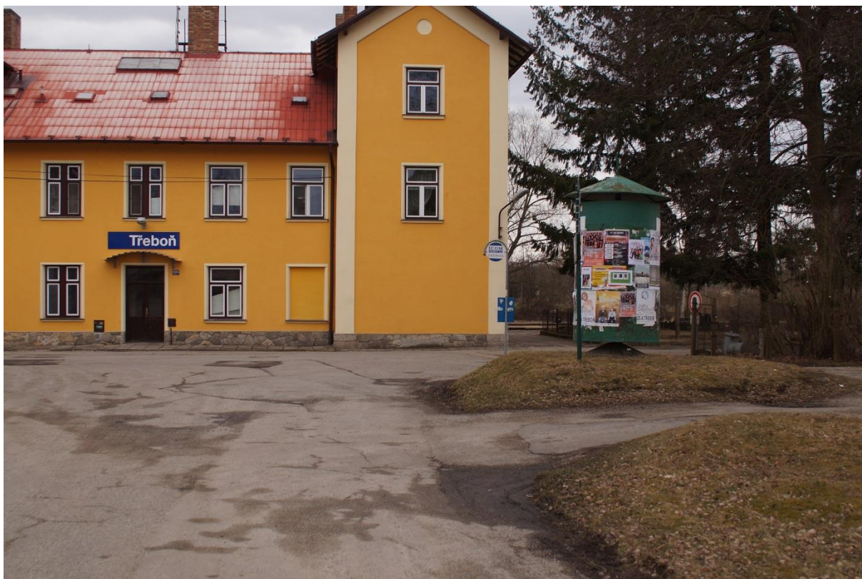
Obrázek 13: Pohled na přednádražní prostor, chybějící autobusovou zastávku a přístup na nástupiště
