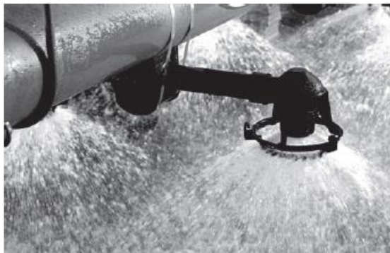
Obrázek 4: Rozprašovací trysky (převzato z [1])
