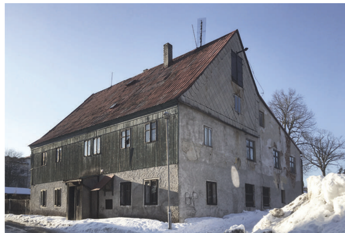
Obr. 27: Typická abertamská chalupa, dům č. p. 17
