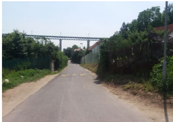
Pohled na železniční most směrem k Louckému klášteru (červen 2018)
