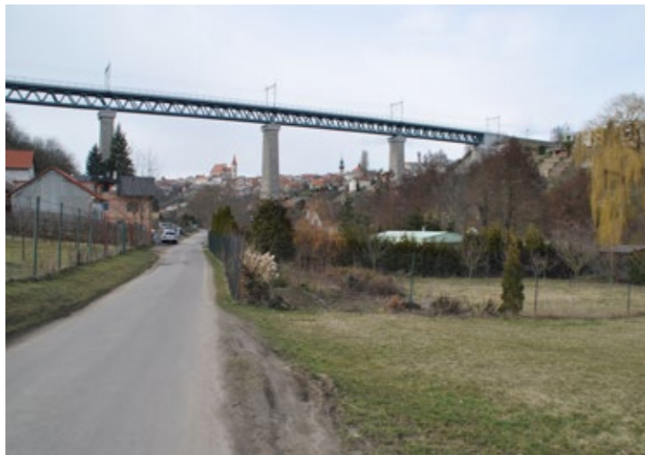
Pohled na železniční most směrem k městu (březen 2018)
