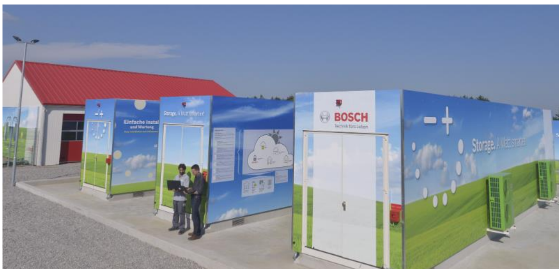
Obrázek 10: Vanadium - redoxový bateriový systém v Braderupu, Německo
