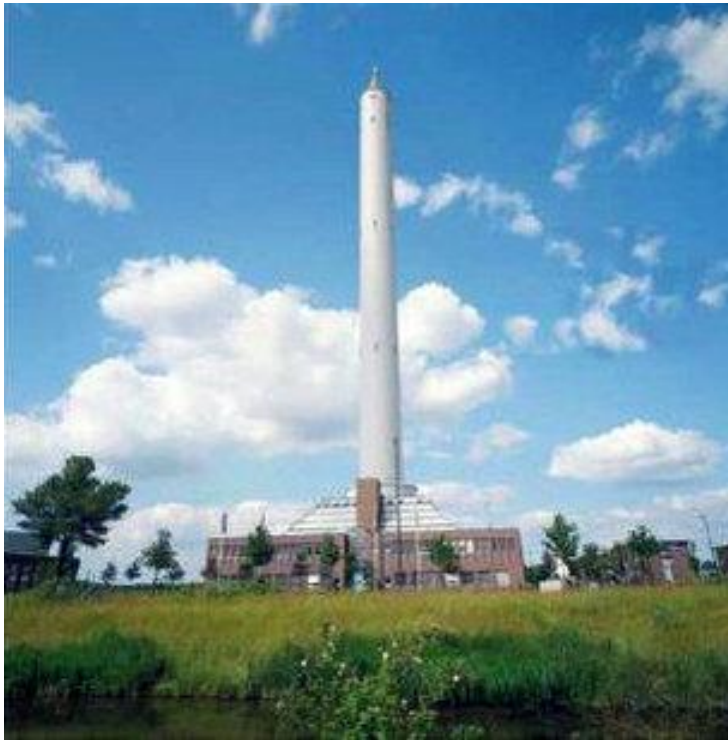
Obr. 5 Pádová věž, Brémy
