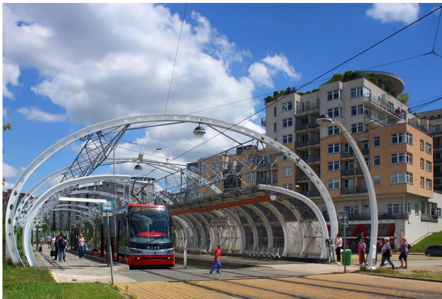
Obrázek 25 - prozatím konečná zastávka Sídliště Barrandov na trati Hlubočepy – Barrandov. Fotografie ukazuje příklad zastřešení nástupišť, zastávka sama dostala konstrukci vlastní jednoznačně identifikovatelný charakter. Obecně se však dá využít výrazně jednodušší a levnější konstrukce se stejným výsledným komfortem pro cestující. (zdroj: mapio.net)
