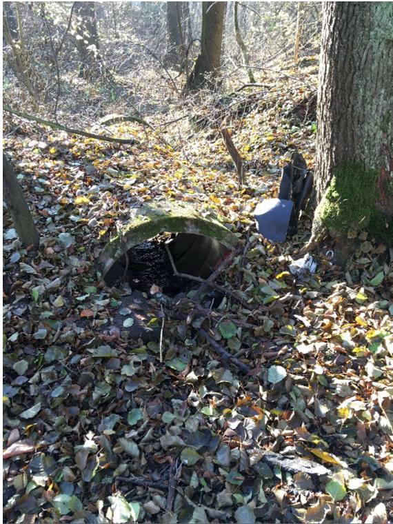
Obrázek 15: Zanesená vpusť do trouby DN1000
