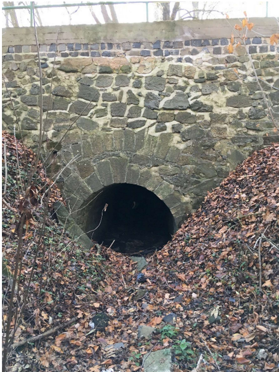
Obrázek 18: Propustek pod silniční komunikací
