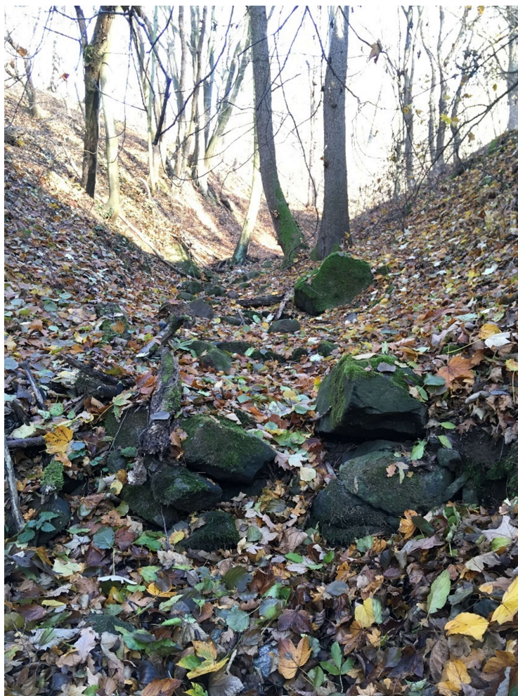
Obrázek 16: Pozůstatky rovnaninového prahu
