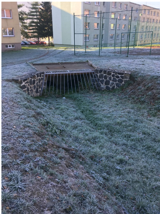
Obrázek 7: Vpust' do zatrubněné části 2x DN1400
