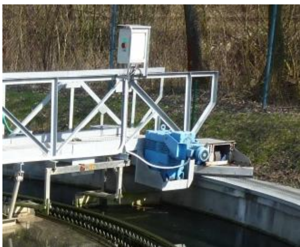
Obrázek 3 Pohon otáčivé lávky pomocí šnekové převodovky [15]
