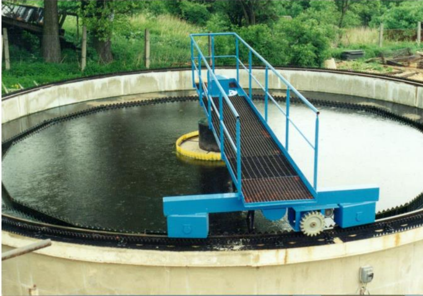
Obrázek 9 Příklad pohonu usazovací nádrže ČOV Praha Ruzyně [20]
