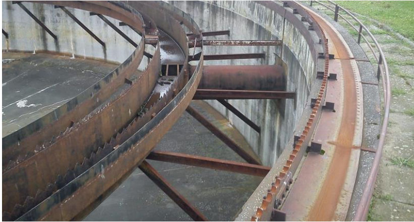
Obrázek 7 Pohon lávky pomocí zubačky a gumového kola [19]
