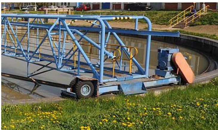
Obrázek 6 Příklad použití gumového kola pro pohon lávky [17]
