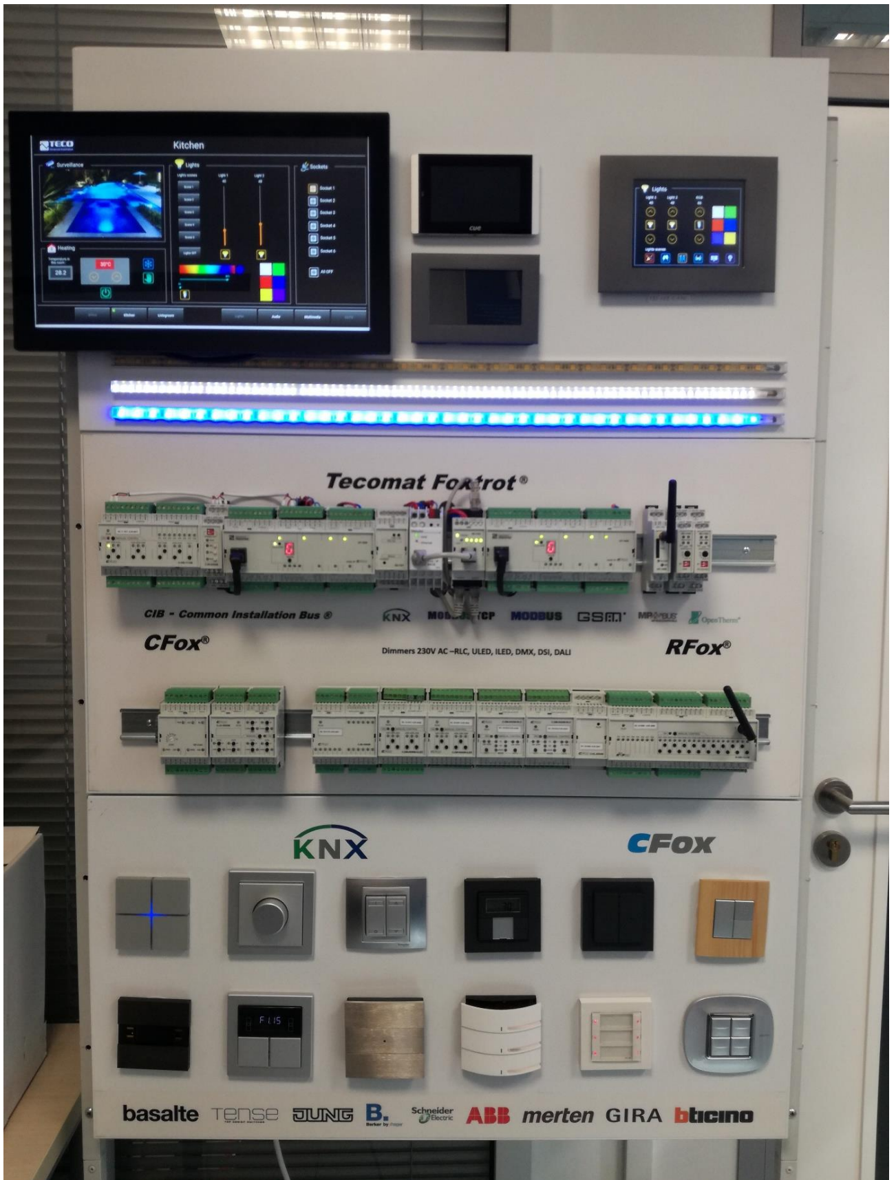
Obrázek 9 - Panel vzájemné komunikace systémů KNX a Tecomat Foxtrot
