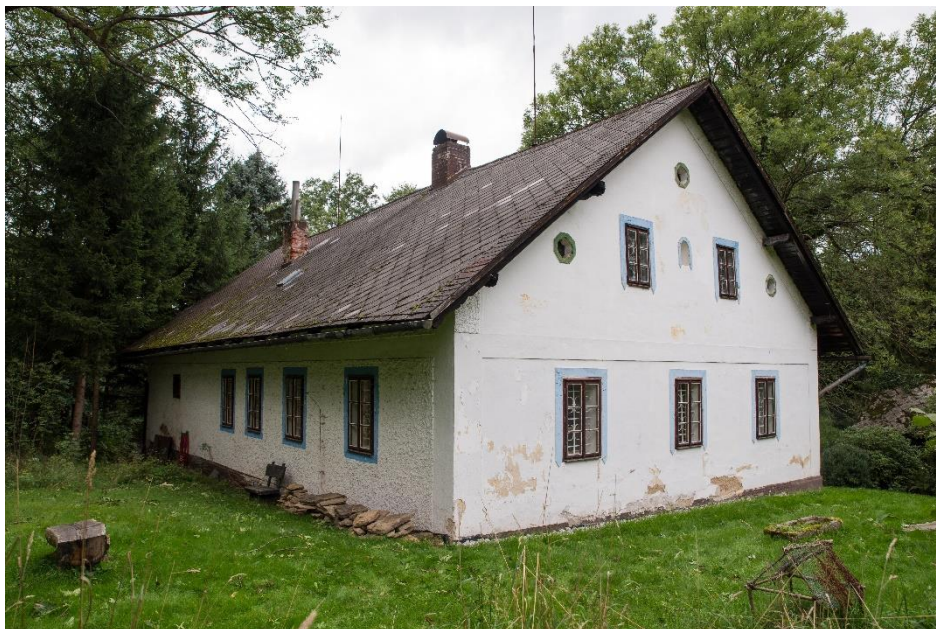
Obrázek 2: Původní stavba – jihovýchodní pohled. (autor – Petr Marek)
