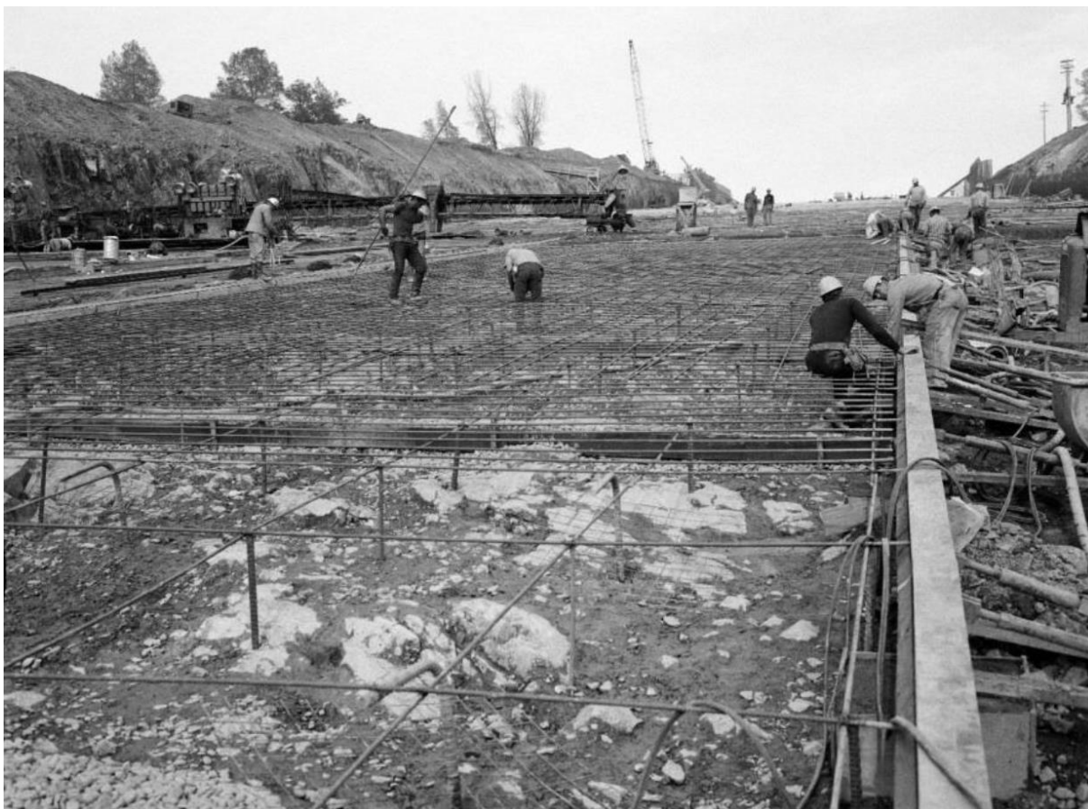
Obr. 6. Očištěná základová spára a příprava betonáže skluzu v roce 1966 [8]
