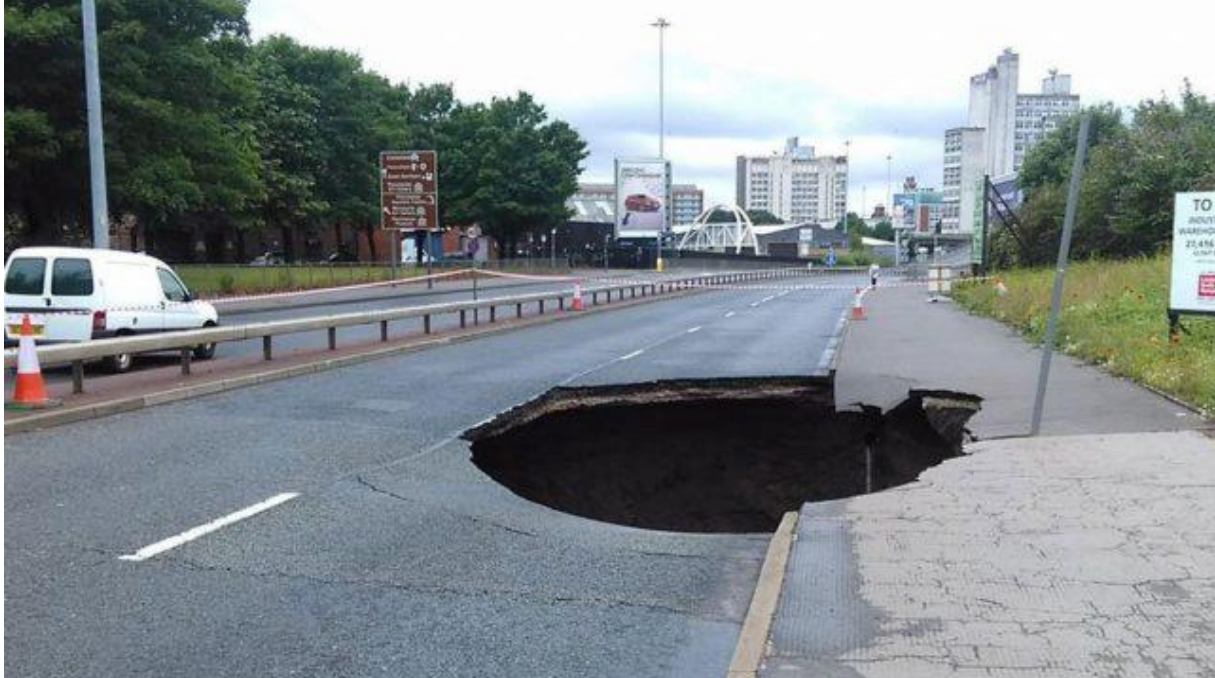
Obr. 9. Netěsné vodovody a netěsné kanalizační stoky vyvolávají vznik kavernózních jevů s intenzifikací jejich vzniku a průběhu otřesy a vibracemi způsobenými dopravním provozem atd.
