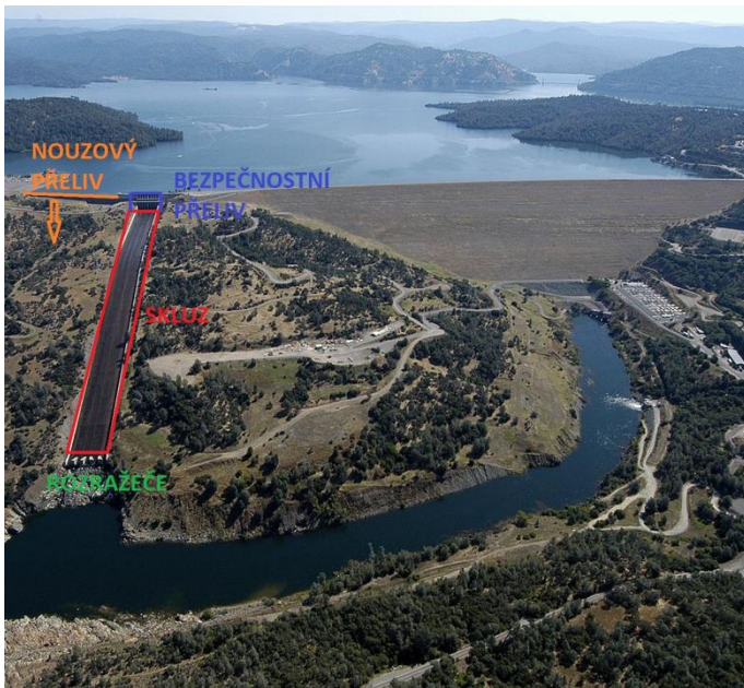
Obr. 1. Pohled na hlavní výpustná zařízení přehrady Oroville.
