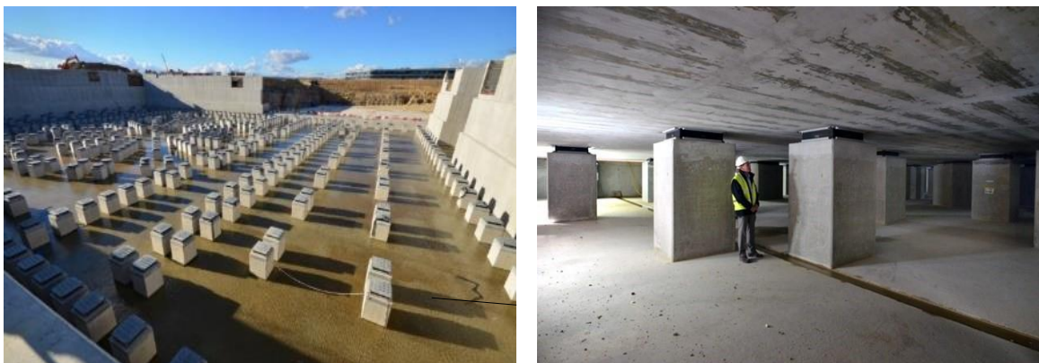
Obr. 3.4 Seismické izolátory reaktoru ITER [A31].
