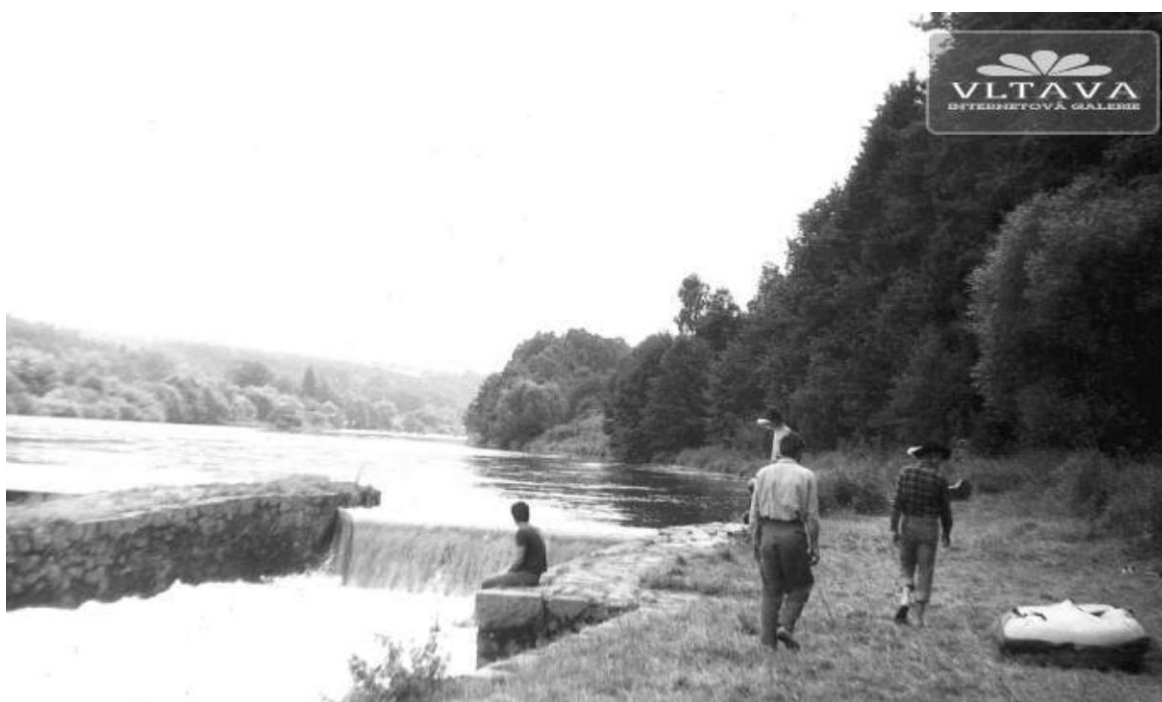
Jez a vorová propust v Jaroslavících. V posledních letech před napuštěním Hněvkovické přehrady byla propust stále uzavřena a lodě se musely přenášet. Pohled z levého břehu proti proudu. Reprodukce fotografie z poloviny 80. let. Archiv Zdeňka Hamra.
