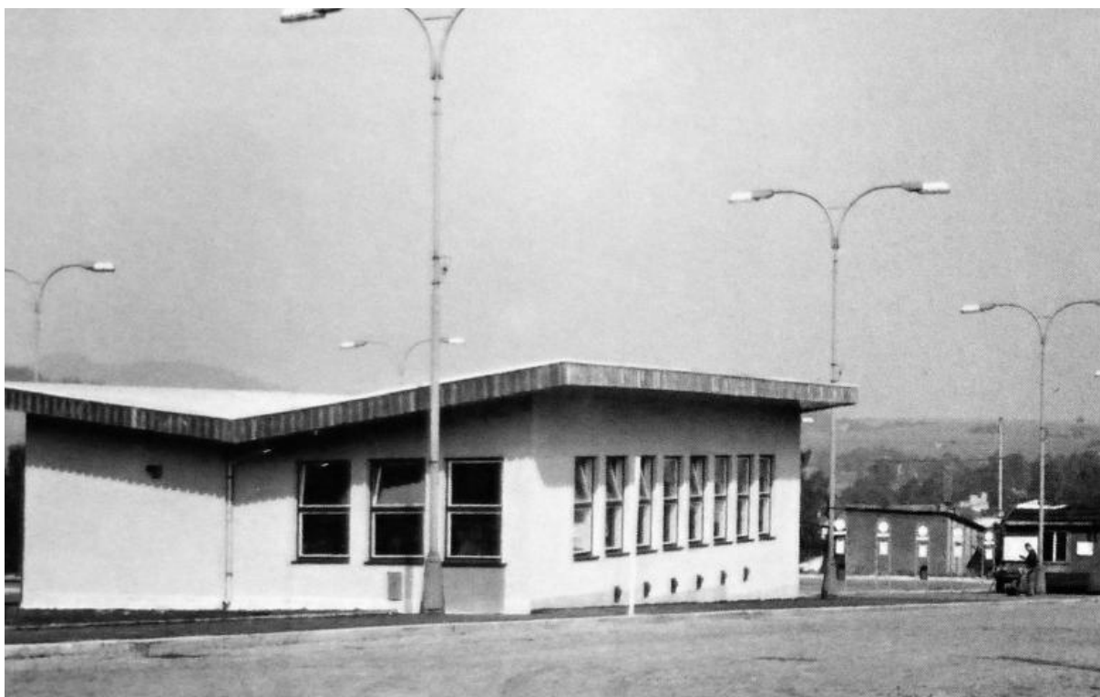
Vzhled výpravní budovy v 70. letech (zdroj Z. Hurych)
