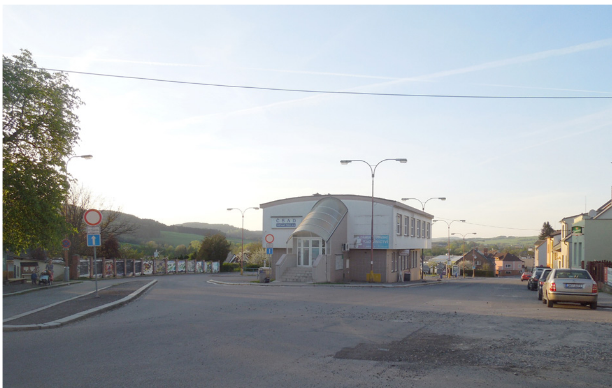
Stávající výpravní budova
