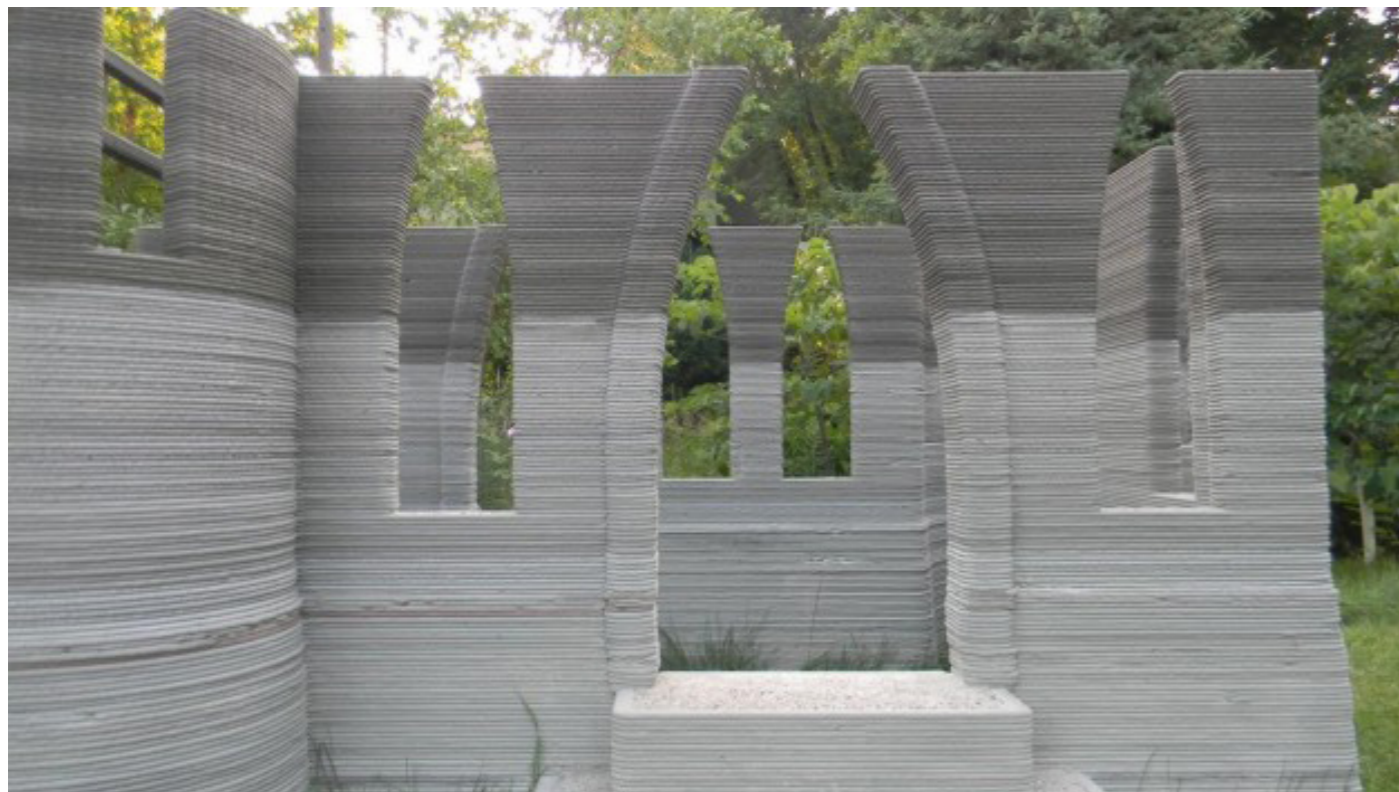
obr. 33 Referenční obrázek znázorňující 3d tisk betonu s přesahme konstrukce bez použití lešení. Převzato z [48]
