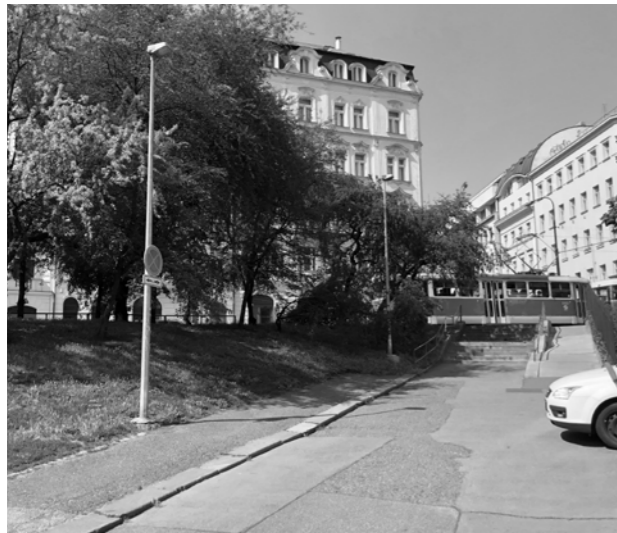
nenavazující chodník na rampu a schodiště
