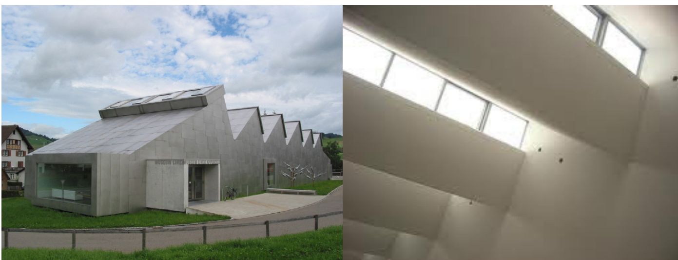
Museum Liner, Gigon/Guyer Architekten, Zdroj: https://www.mimoo.eu/projects/Switzerland/Appenzell/Museum%20Liner/ , https://arch3281fall14.wordpress.com/2014/09/17/reading-2-project-2-1-abby-alldaffer-museum-liner-appenzell/ (Pilová střecha se zmenšujícími světlíky přivádí do prostorů nepřímé severní světlo. Pilová střecha reaguje na své okolí.)
