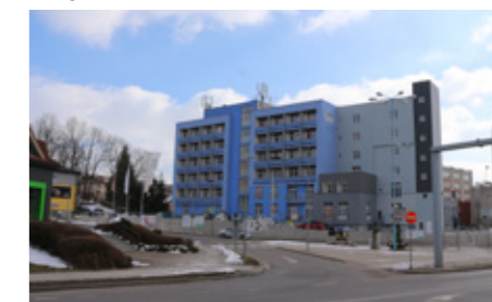
6 bytový dům (bývalý hotel Rekrea)
