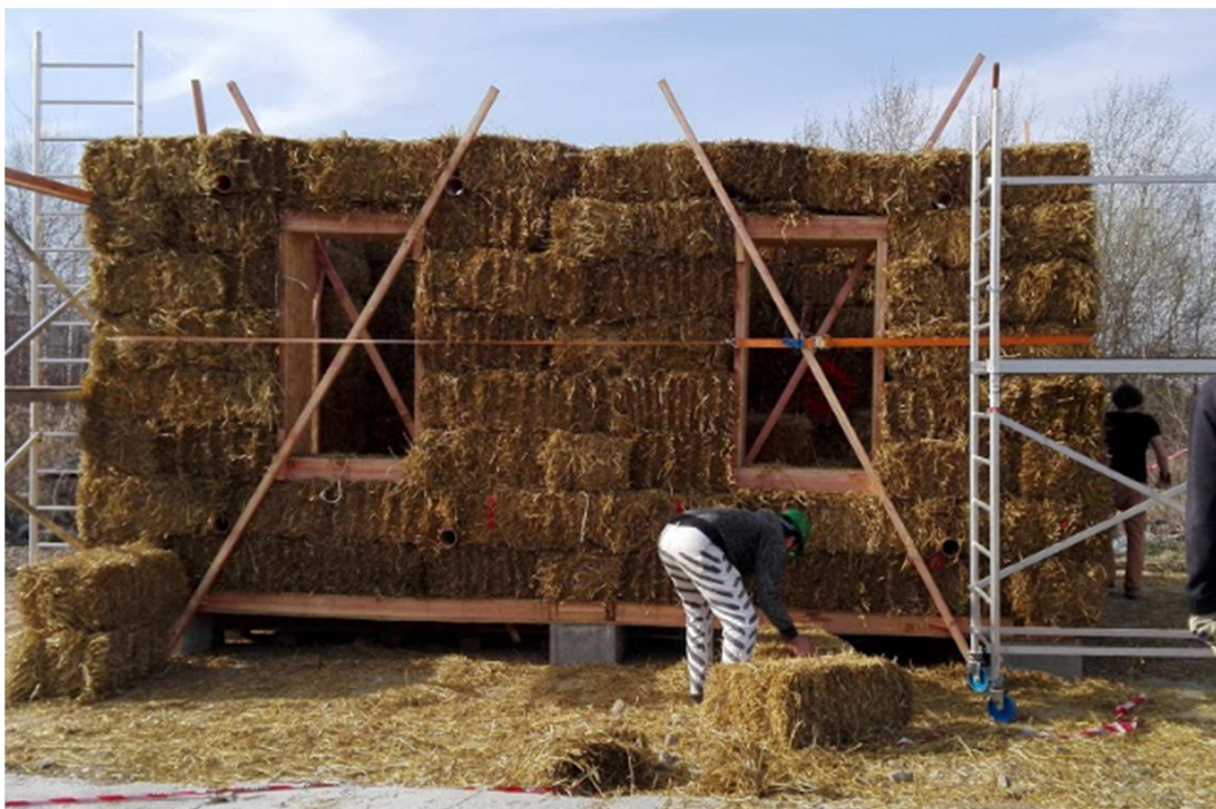
Obr. č. 13 Navrstvené slaměné balíky
