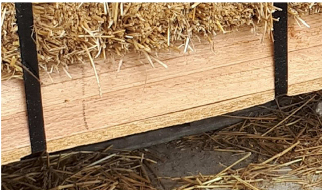
Obr. č. 20 Zařezávání ocelové pásky do dřevěné konstrukce nosného věnce
