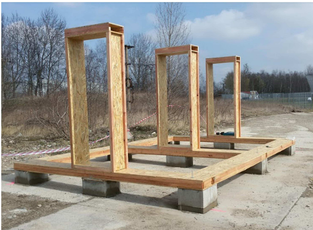
Obr. č. 12 Osazené dřevěné kastlíky pro dveře
