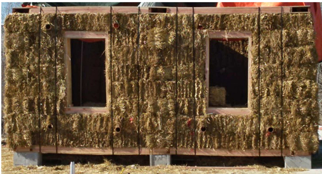
Obr. č. 14 Konstrukce stabilizována ocelovými páskami
