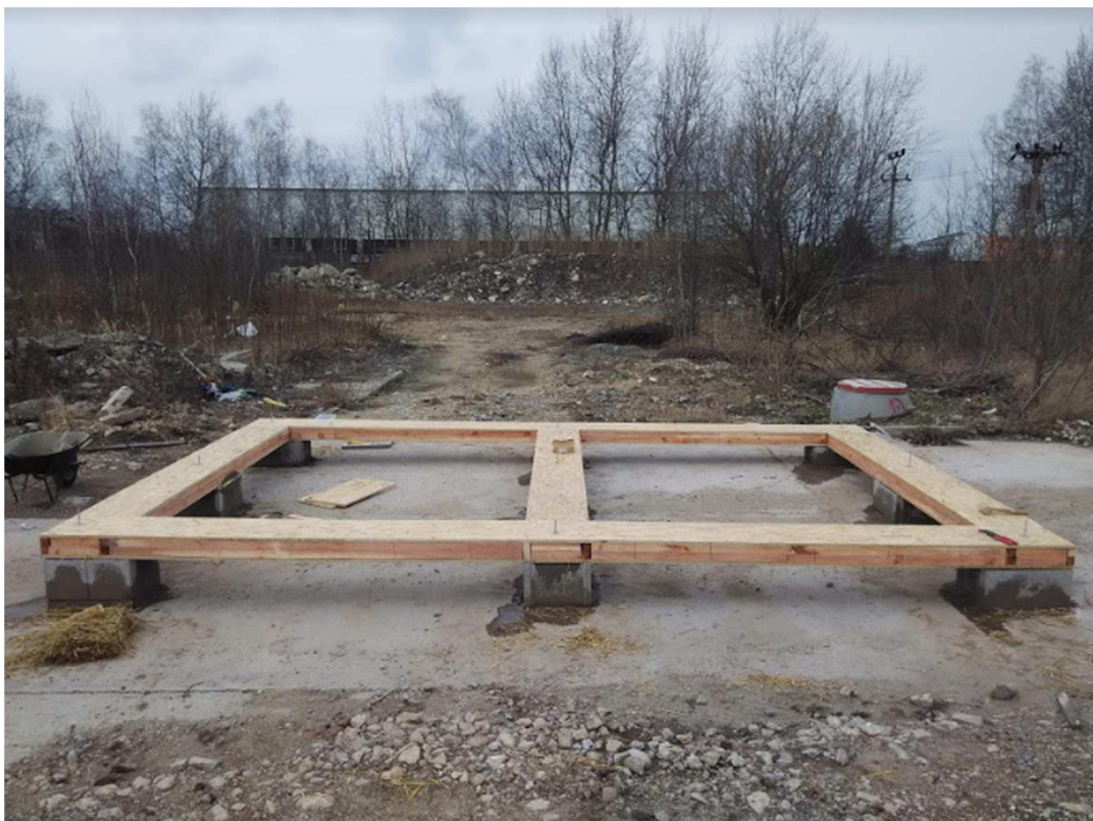
Obr. č. 11 Osazené betonové tvarovky spolu se spodním nosným věncem
