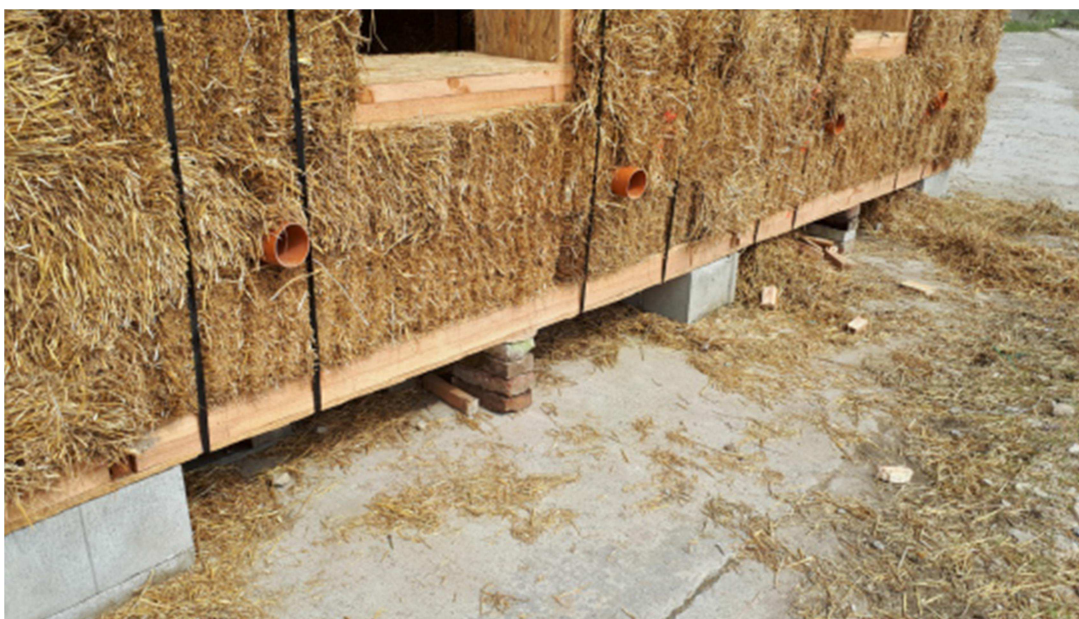
Obr. č. 19 Provizorní podepření spodního nosného věnce
