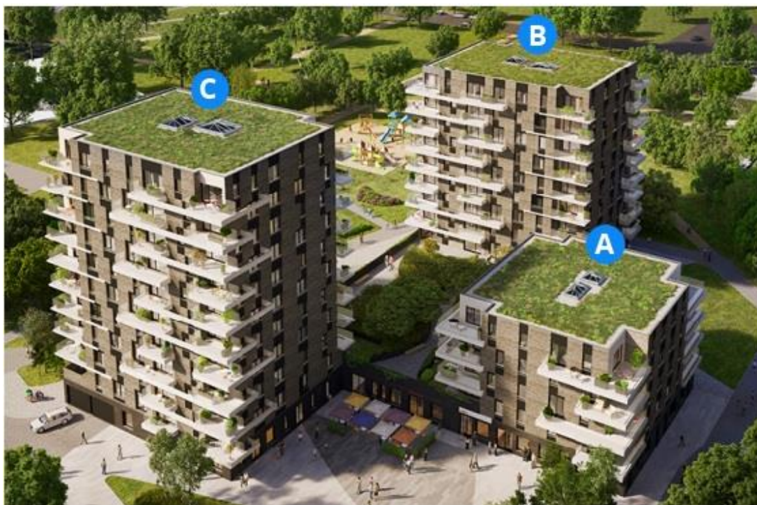
Obrázek 15: Polyfunkční dům Kindergarten [8]
