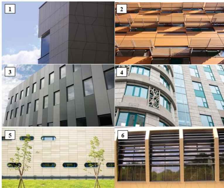
Obr. 8: Materiálové varianty obkladu (1 - vlákno-cement, 2 - vysoko-pevnostní laminát, 3 - kov, 4 - kámen, 5 - terakota, 6 - kompozitní materiál) [9]
