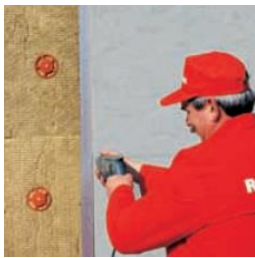
Obr. 16: Montáž obkladových desek [20]
