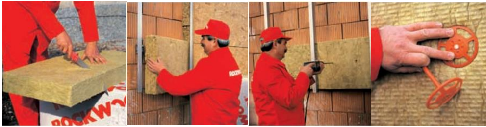
Obr. 15: Nařezání dílů, vložení izolace mezi nosné profily, vrtání otvorů pro kotvení, kotvení izolace [20]
