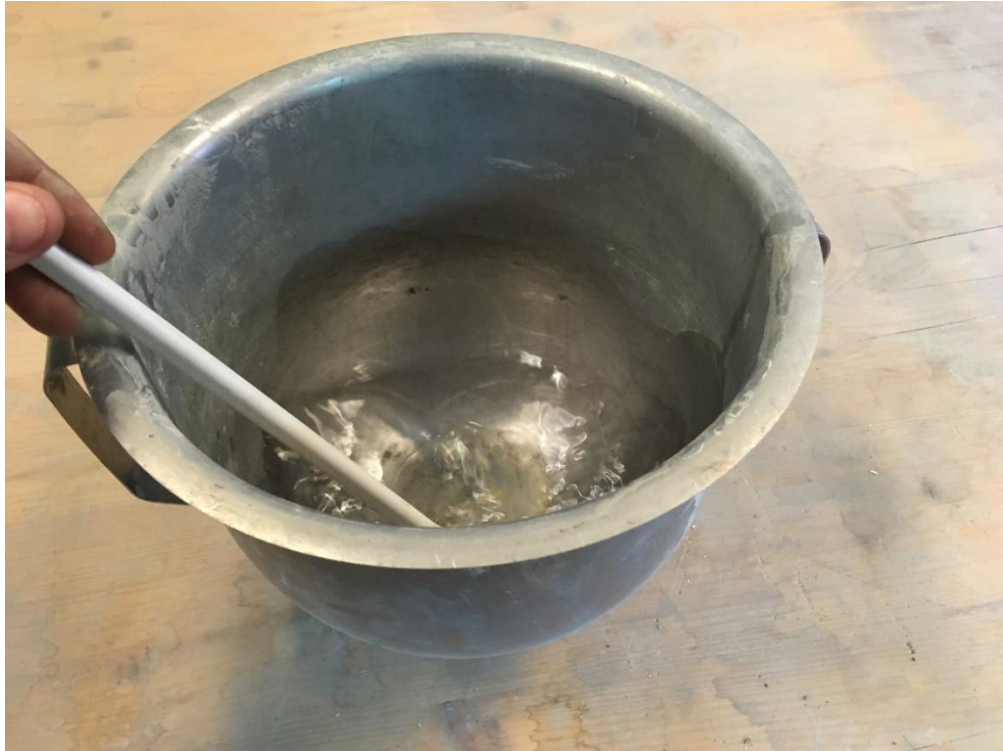
Obr. 2.5 Ruční „před míchání“ záměsové vody s přísadou
