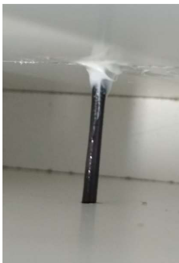
Obr. 21 – silikonový kužel pro zamezení popraskání betonu (foto: Žalský)
