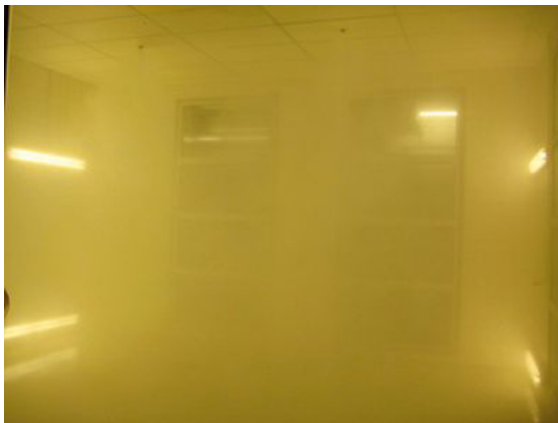
- Obr.12 - Místnost po aktivaci vysokotlakého SHZ [7]
