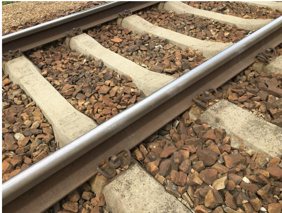
Foto č. 25 – Bezpodkladnicové upevnění W14 na pražci B91S
