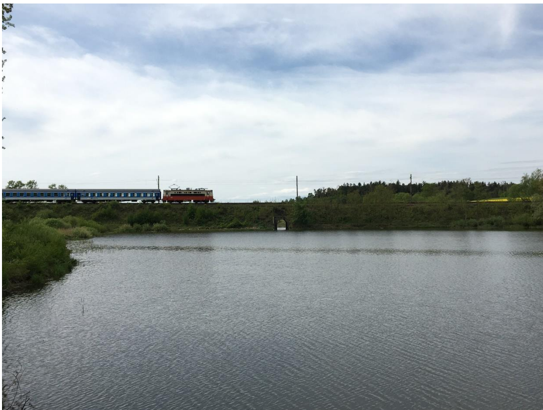
Foto č. 32 – Vedení trasy po náspu přes rybník Ochoz u Mnichu v km 15,760
