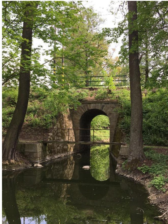
Foto č. 26 – Kamenný most v km 13,922
