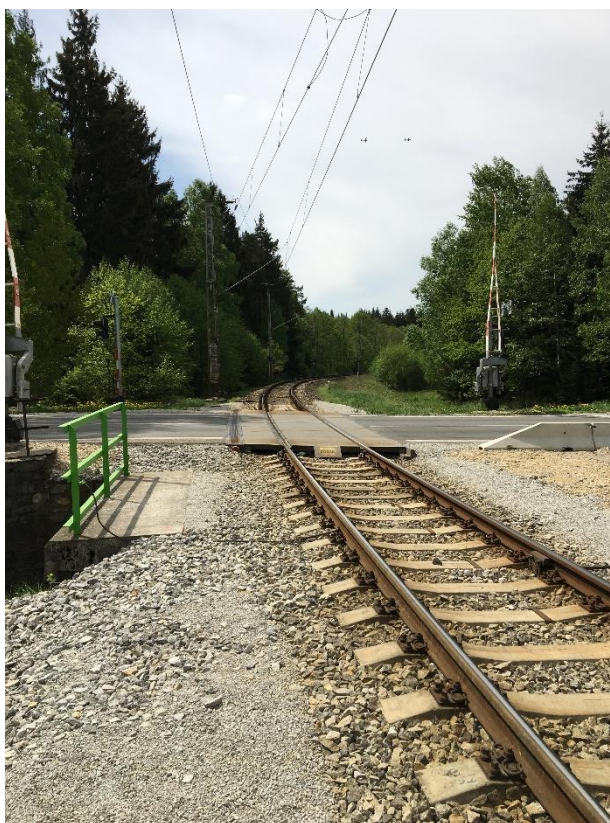
Foto č. 11 – Přejezd P6156 v km 19,363 proti směru staničení
