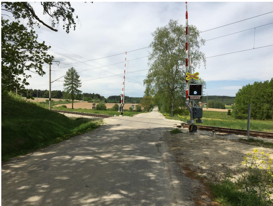
Foto č. 17 – Přejezd P6158 v km 22,294
