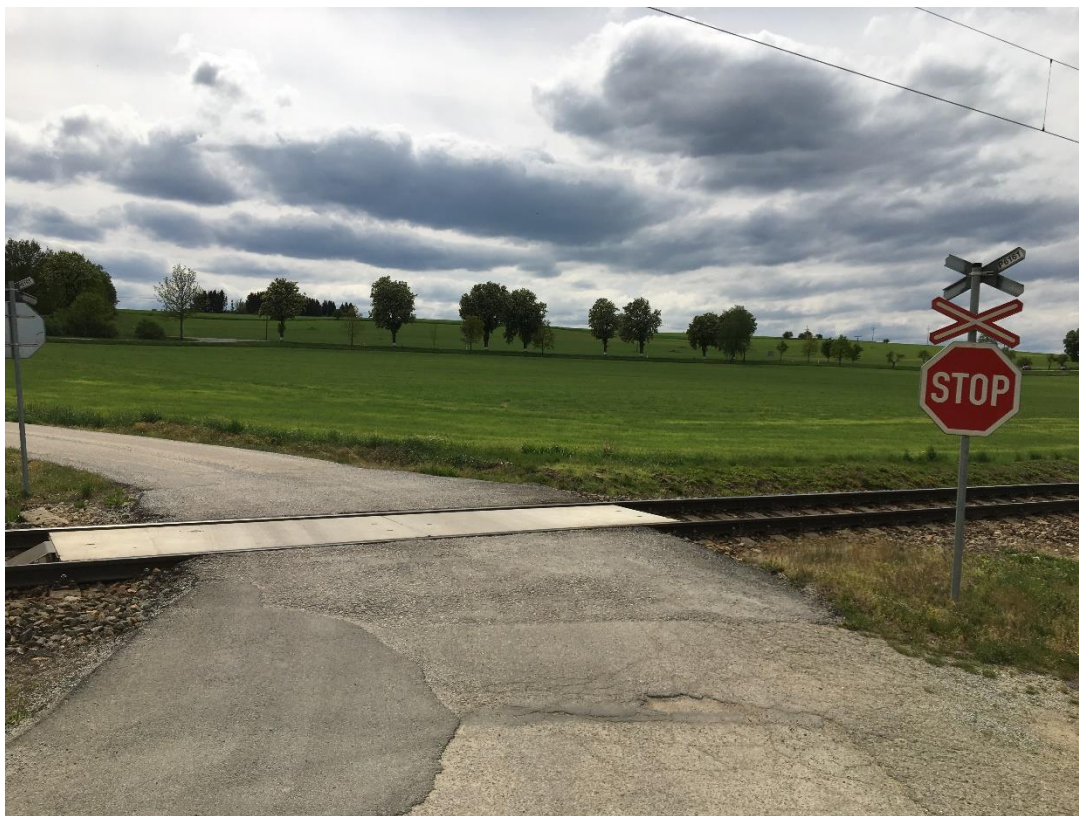
Foto č. 18 – Přejezd P6161 v km 24,796
