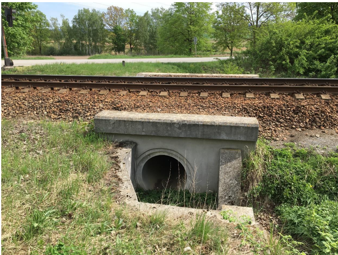
Foto č. 28 – Trubní propustek v km 15,033
