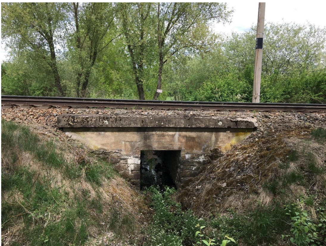
Foto č. 29 – Propustek v km 22,993
