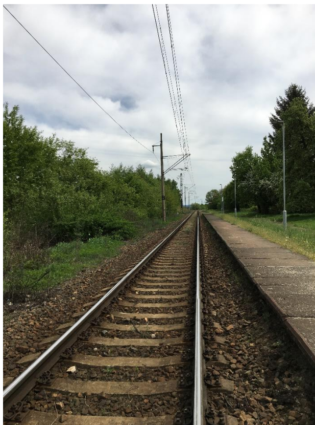
Foto č. 15 – Nástupiště v zastávce Děbolín ve směru staničení
