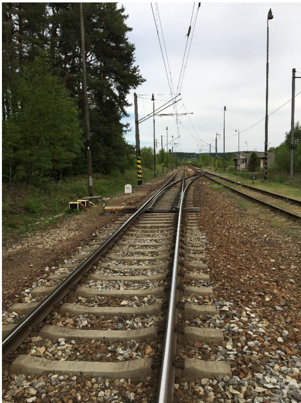
Foto č. 13 – Výhybka č. 1 v km 19,488 ve směru staničení; typ J49 – 1:9 – 300
