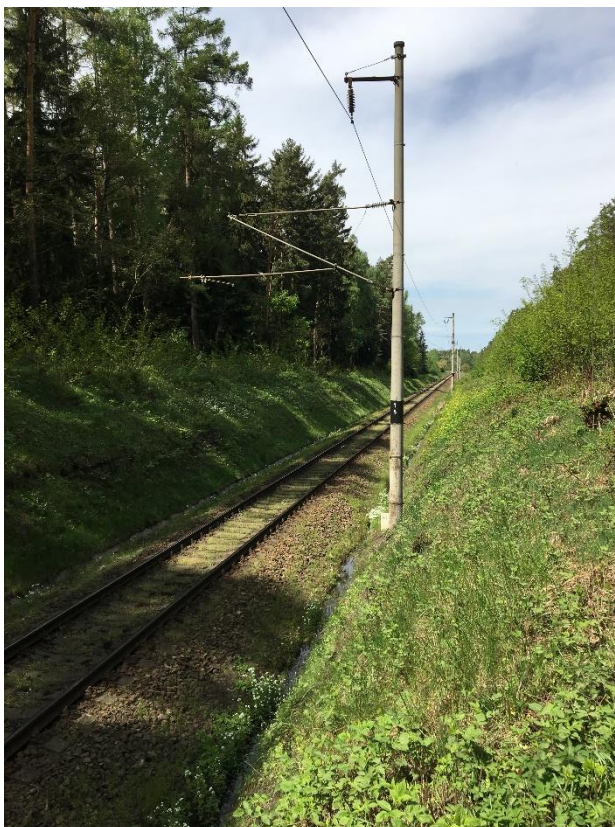
Foto č. 8 – Úsek v km 17,800 proti směru staničení
