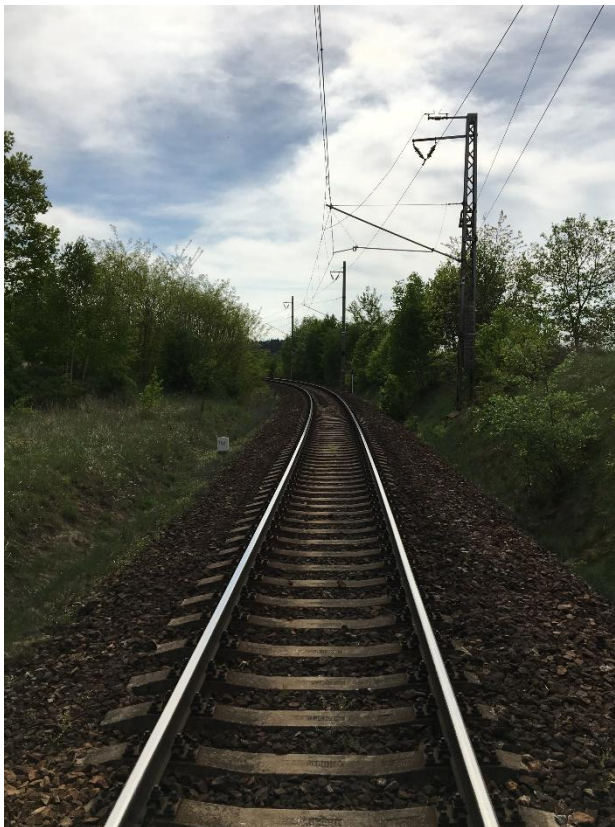
Foto č. 3 – Směrový oblouk v km 14,100 ve směru staničení
