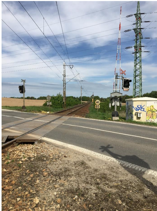
Foto č. 5 – Přejezd P6151, pohled proti směru staničení
