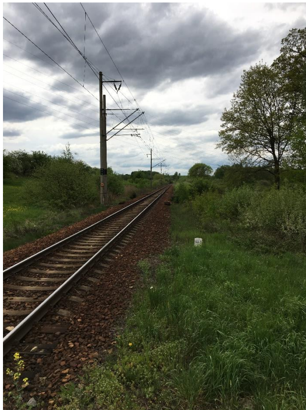
Foto č. 19 – Trať v km 25,700 proti směru staničení
