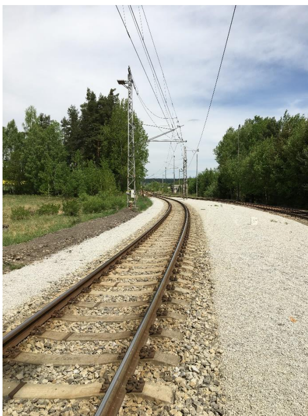
Foto č. 12 – Směrový oblouk v km 19,400 ve směru staničení
