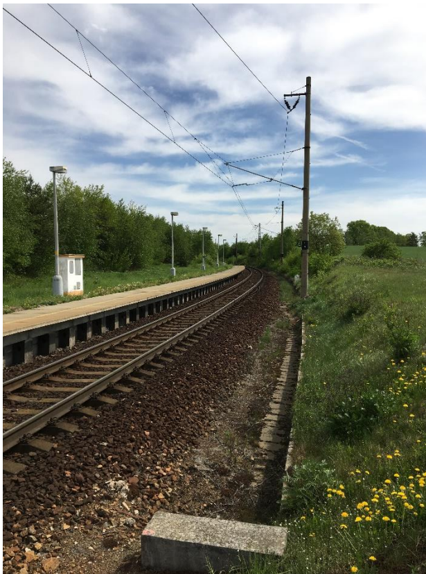
Foto č. 7 – Nástupiště v zastávce Mnich ve směru staničení
