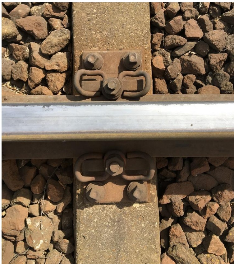
Foto č. 23 - Upevnění KS se svěrkou Skl 24 na pražci SB 8P
