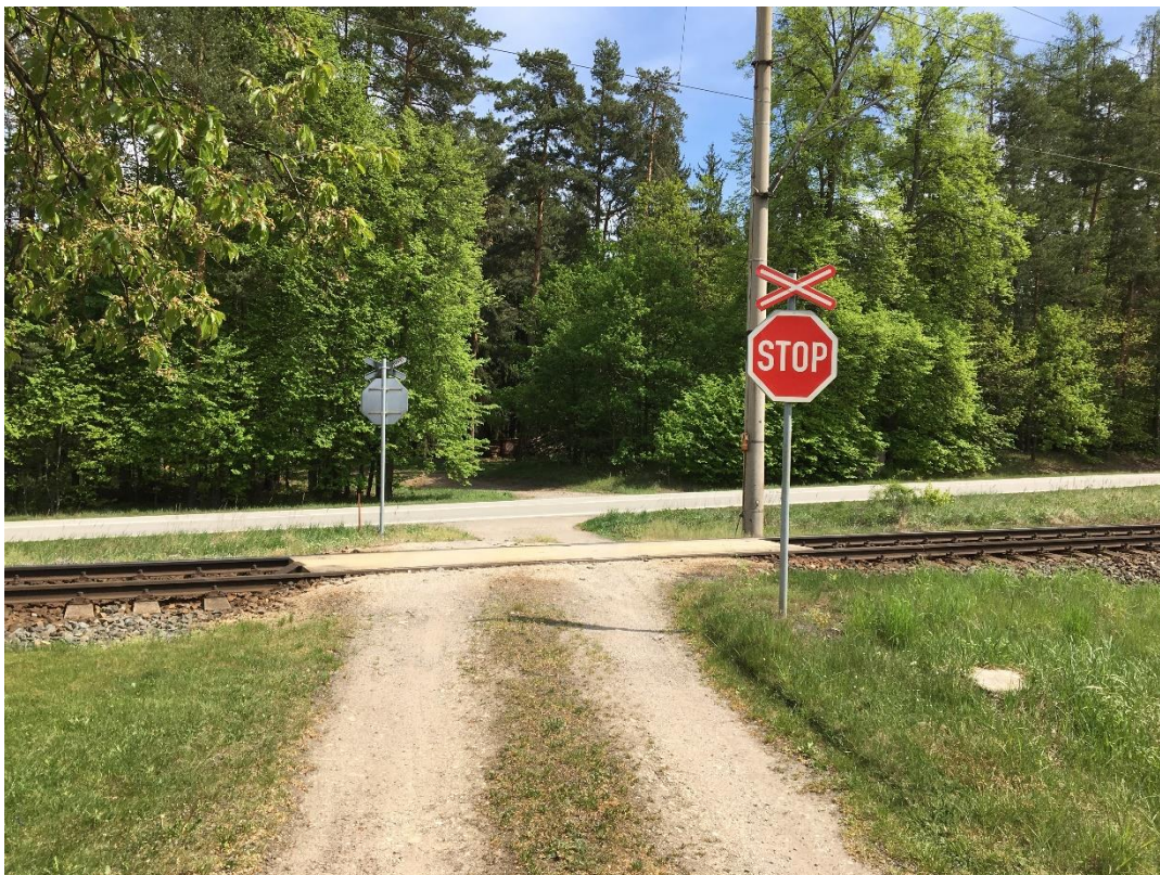
Foto č. 10 – Přejezd P6155 v km 17,456
