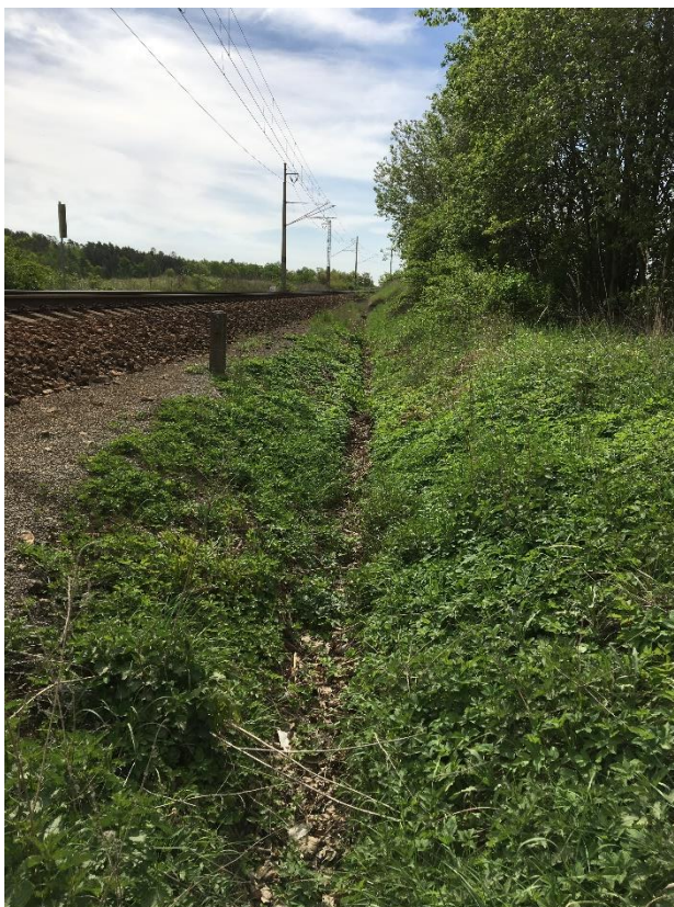
Foto č. 4 – Nezpevněný, zarostlý příkop v km 15,100
