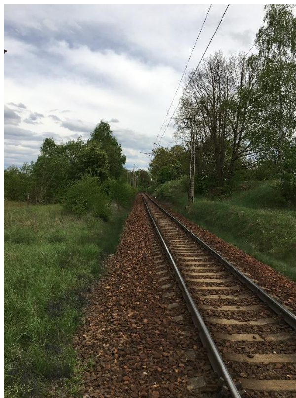
Foto č. 20 – Trať v km 25,700 ve směru staničení
