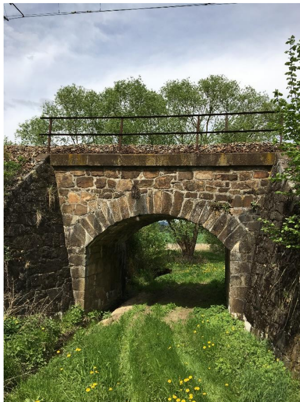
Foto č. 27 – Mostní objekt v km 23,598
