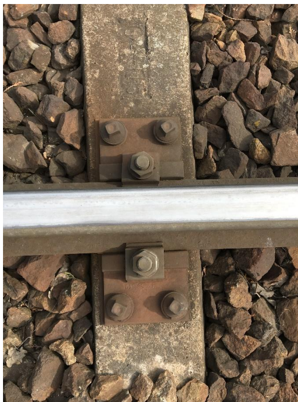
Foto č. 24 - Upevnění K s tuhou svěrkou ŽS 4 na pražci SB 8P
