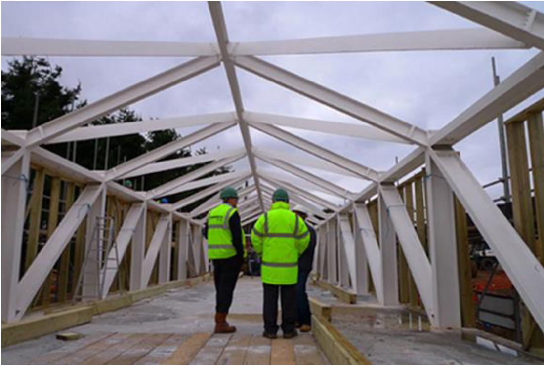
Obrázek 11 - Balancing Barn – nosná ocelová konstrukce během výstavby [7]
