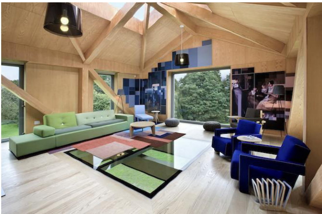
Obrázek 12 - Balancing Barn – výsledné zakrytí ocelové konstrukce dřevěným obkladem [7]
