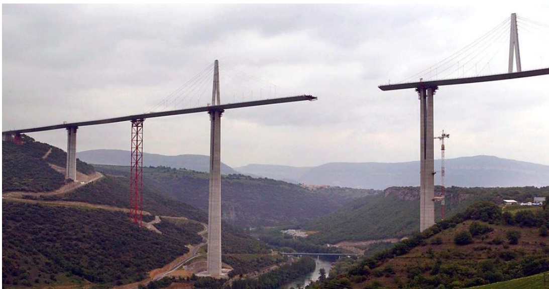
Obrázek 34 - Viadukt Millau – vysouvání mostovky [24]
