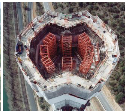
Obrázek 33 - Viadukt Millau - řez pilířem (foto) [23]
