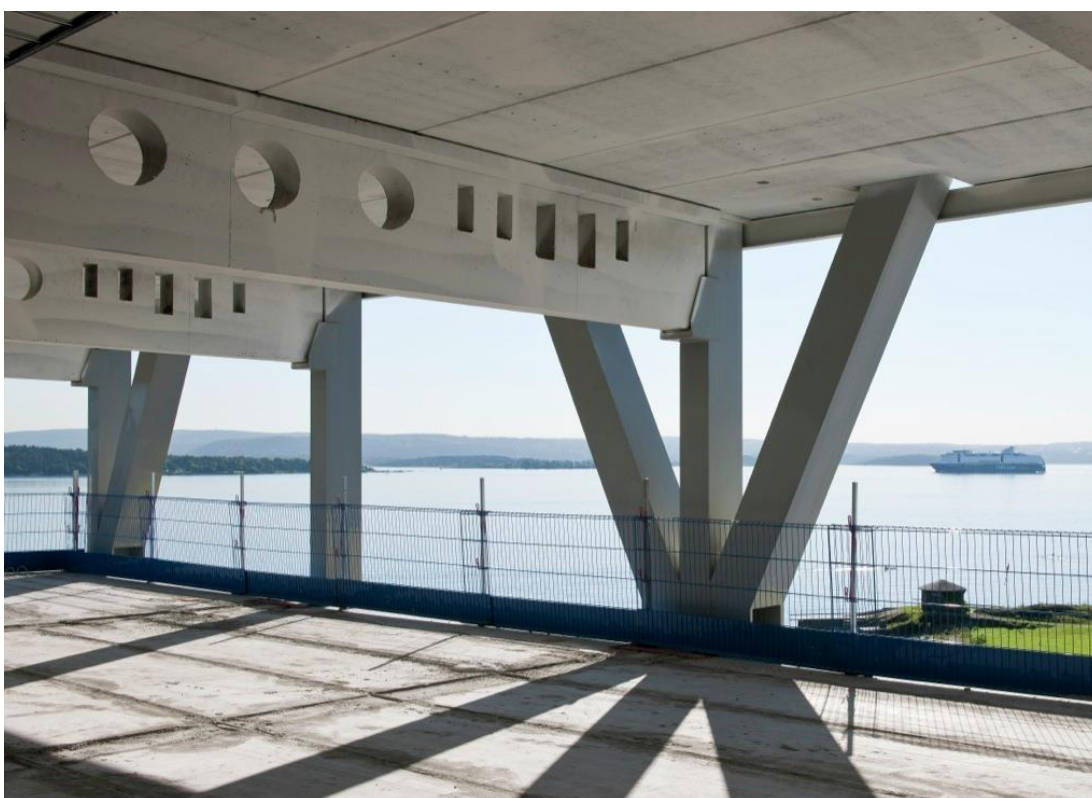
Obrázek 26 - Statoil – Uložení betonových vazníků do kapsy na příhradové konstrukci [16]
