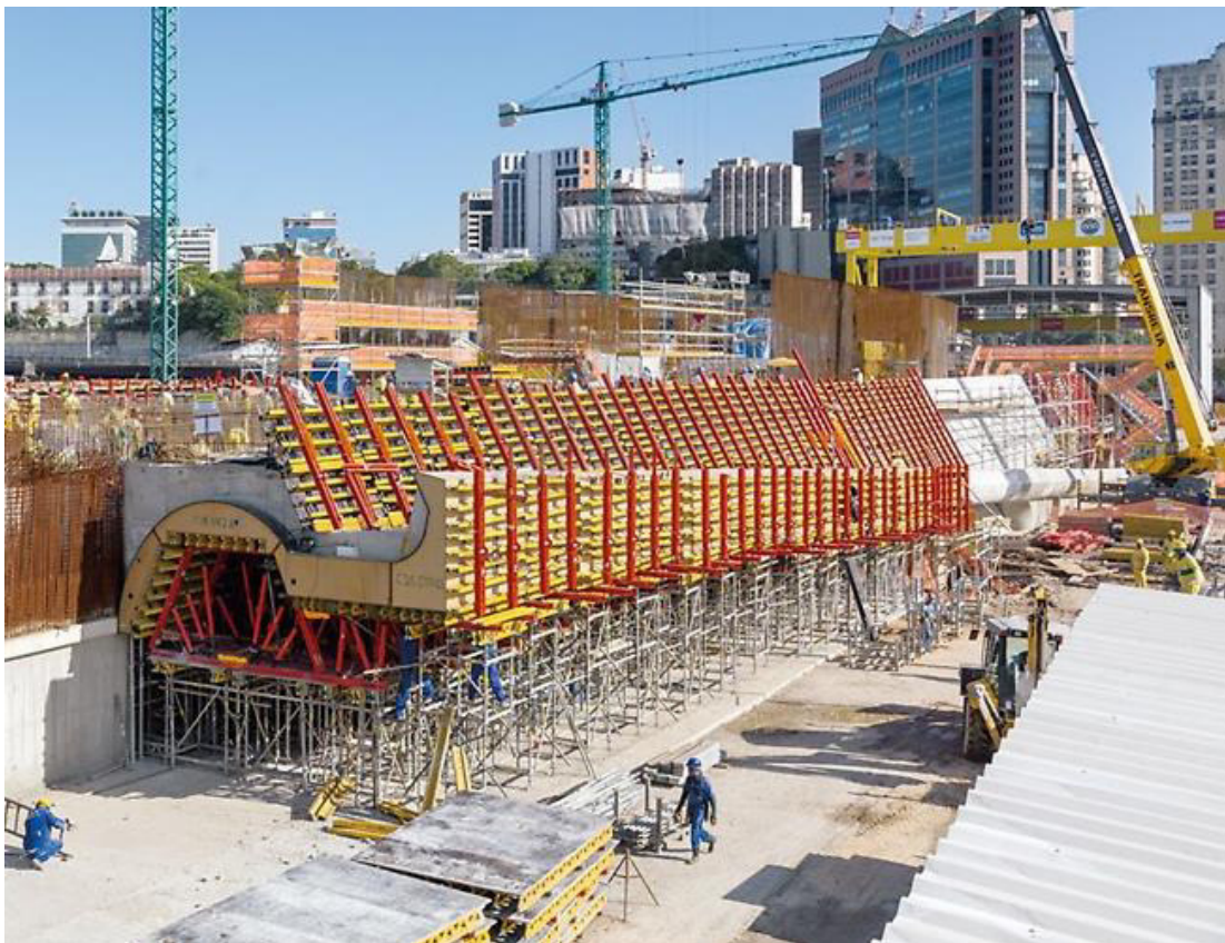
Obrázek 20 - Museum of Tomorrow – detail bednění krajní části [14]
