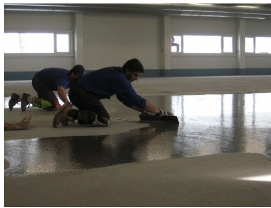
Obrázek 21: Provádění stěrky
