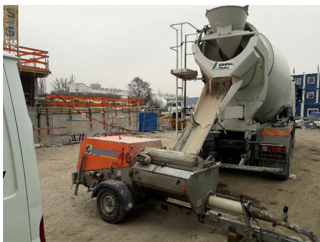
Obrázek 30: Vykládání a čerpání lité anhydritové směsi
