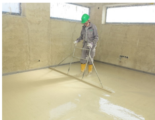
Obrázek 26 Hutnění anhydritového potěru
