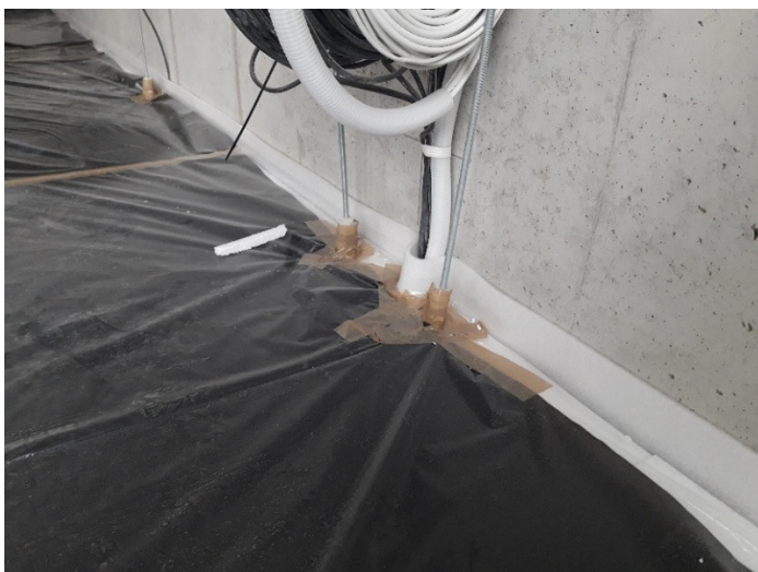
Obrázek 32: Detail utěsnění prostupů
