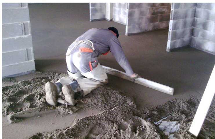
Obrázek 7: Ukládání potěru ze zavlhlé směsi
