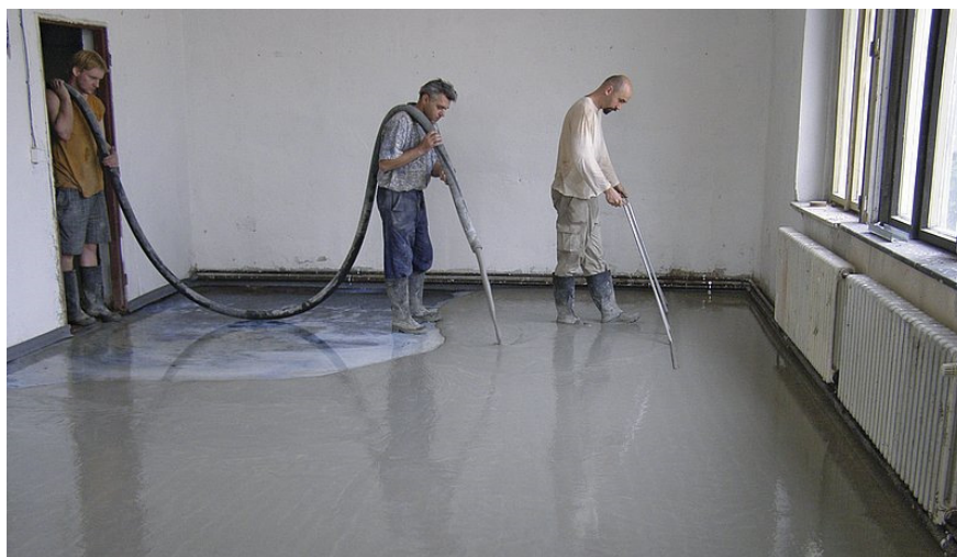
Obrázek 8: Ukládání potěru z lité směsi
