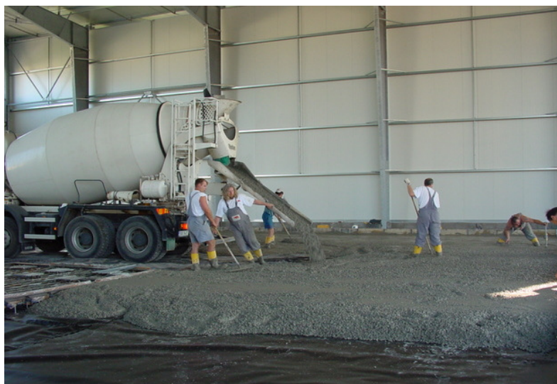
Obrázek 9 Ukládání potěru z betonové směsi
