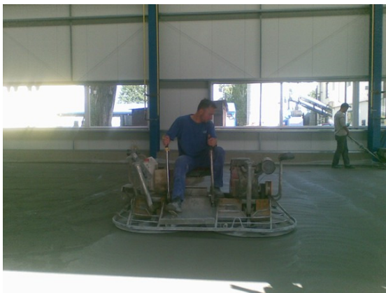
Obrázek 22: Hlazení povrchu s minerálním vsypem
